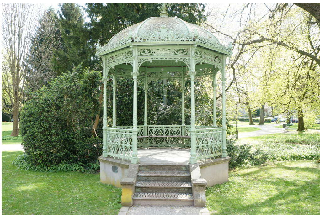
Ensemble Museum Lindengut, Gartenpavillon (230STPAVILL00039), Ansicht von W, 15.04.2014 (Bild Nr. D100639_33).
