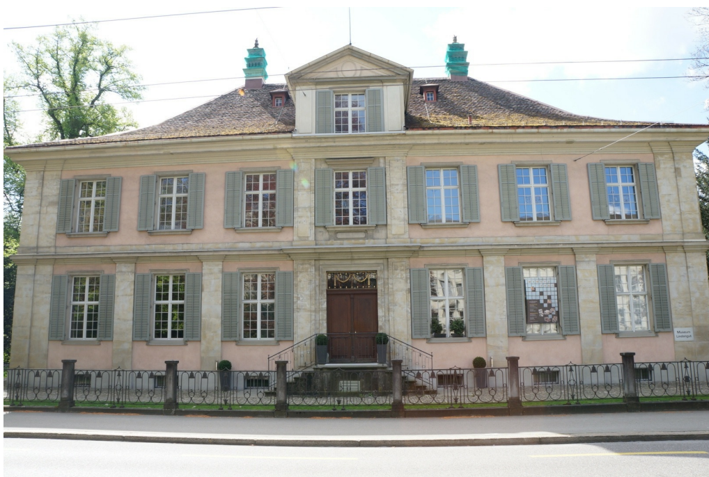
Ensemble Museum Lindengut, Museum, ehem. Wohnhaus (230ST00039), Ansicht von N, 15.04.2014 (Bild Nr. D100639_29).
