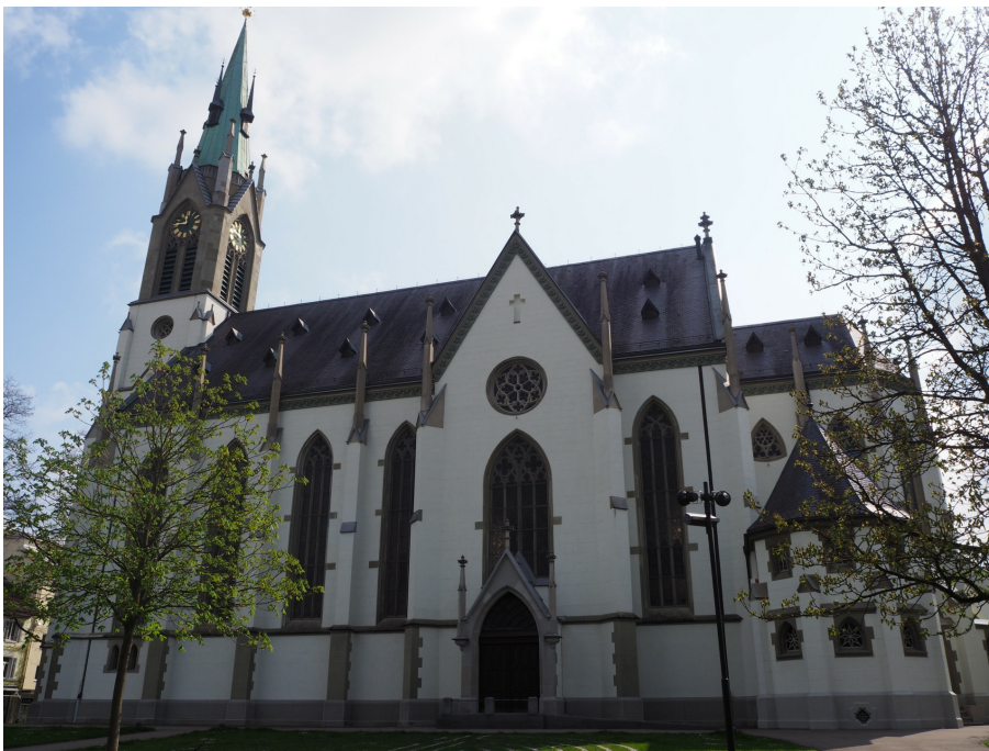
Kath. Kirche St. Peter und Paul, Ansicht von W, 06.04.2017 (Bild Nr. D101130_57).
