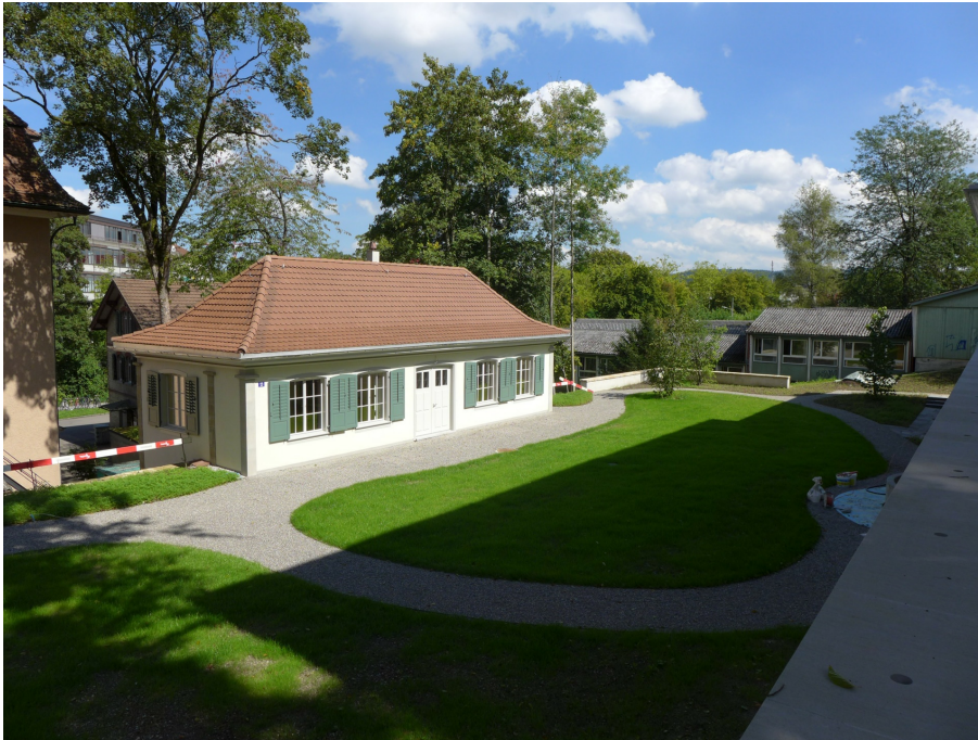
Ensemble «Schanzengarten», Gartenhaus (230ST07926), Ansicht von W, 15.04.2014 (Bild Nr. D100638_18).
