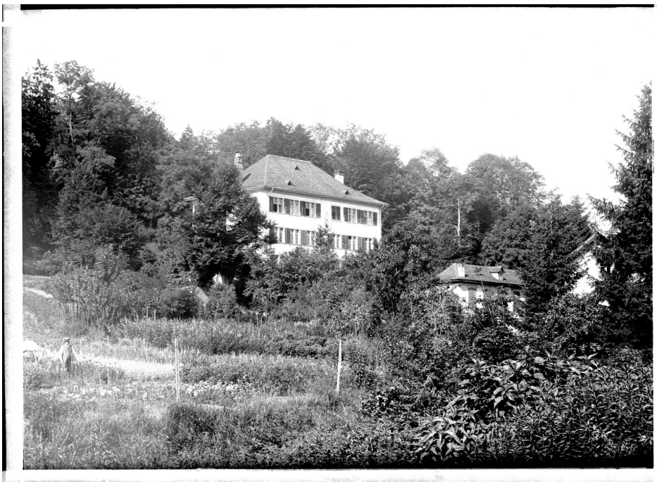
Ensemble «Schanzengarten», Ansicht von NO, 12.07.1926 (Bild Nr. Z05611).
