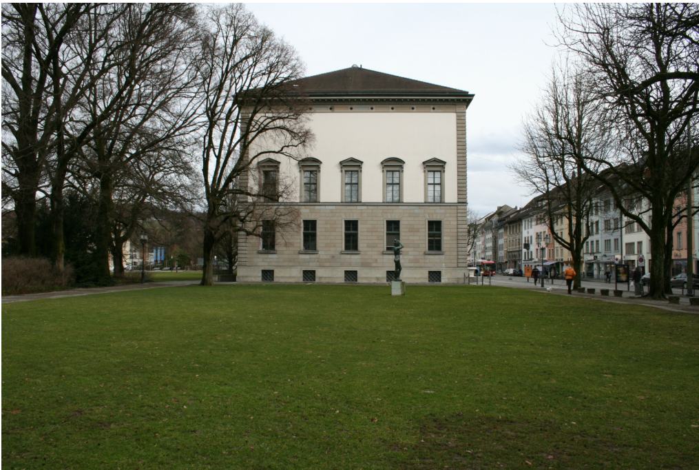
Museum Oskar Reinhart, ehem. Knabengymnasium und Gewerbeschulhaus, Ansicht von W, 28.02.2017 (Bild Nr. D101127_04).
