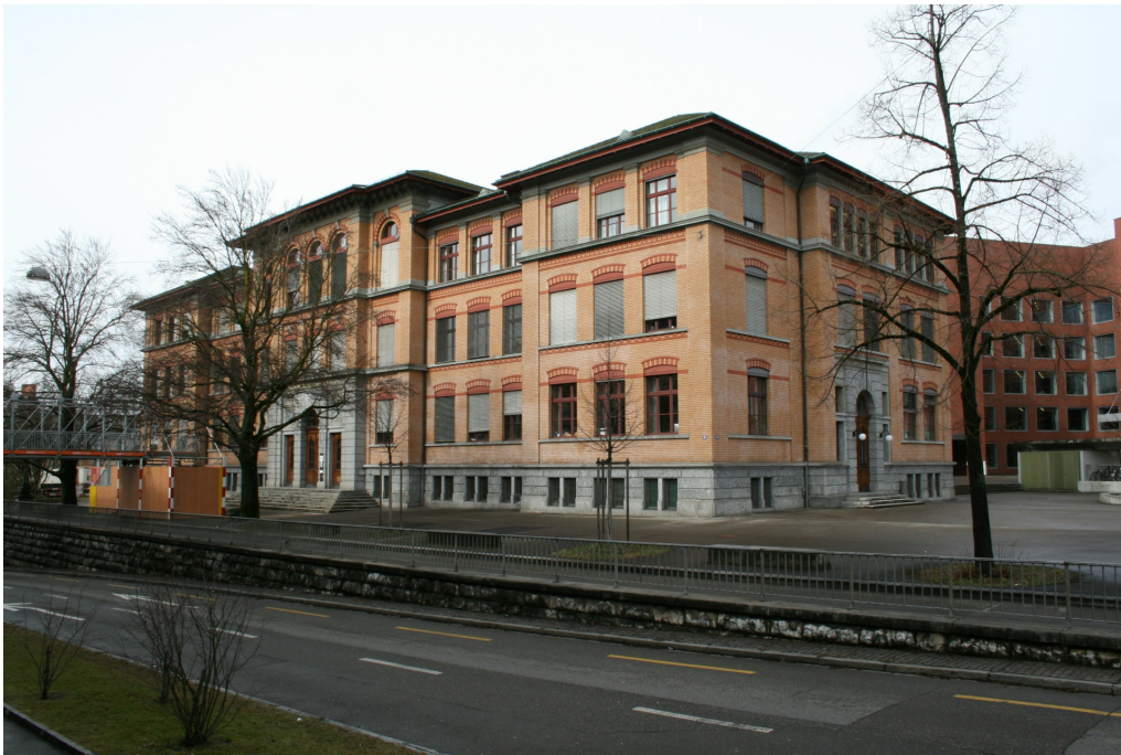
Schulhaus St. Georgen, Ansicht von SO, 28.02.2017 (Bild Nr. D101127_50).
