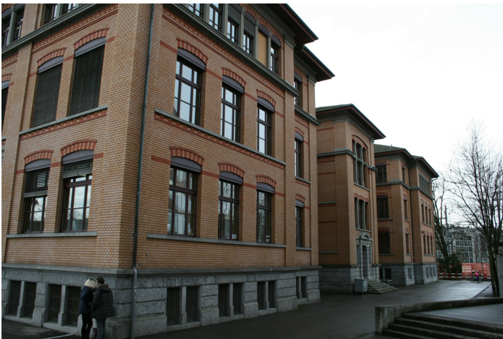
Schulhaus St. Georgen, Ansicht von NO, 28.02.2017 (Bild Nr. D101127_53).
