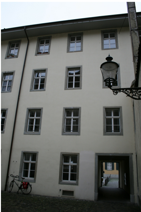
Alterswohnheim, ehem. «Oberer Spital», Ansicht von N, 21.03.2017 (Bild Nr. D101134_75).
