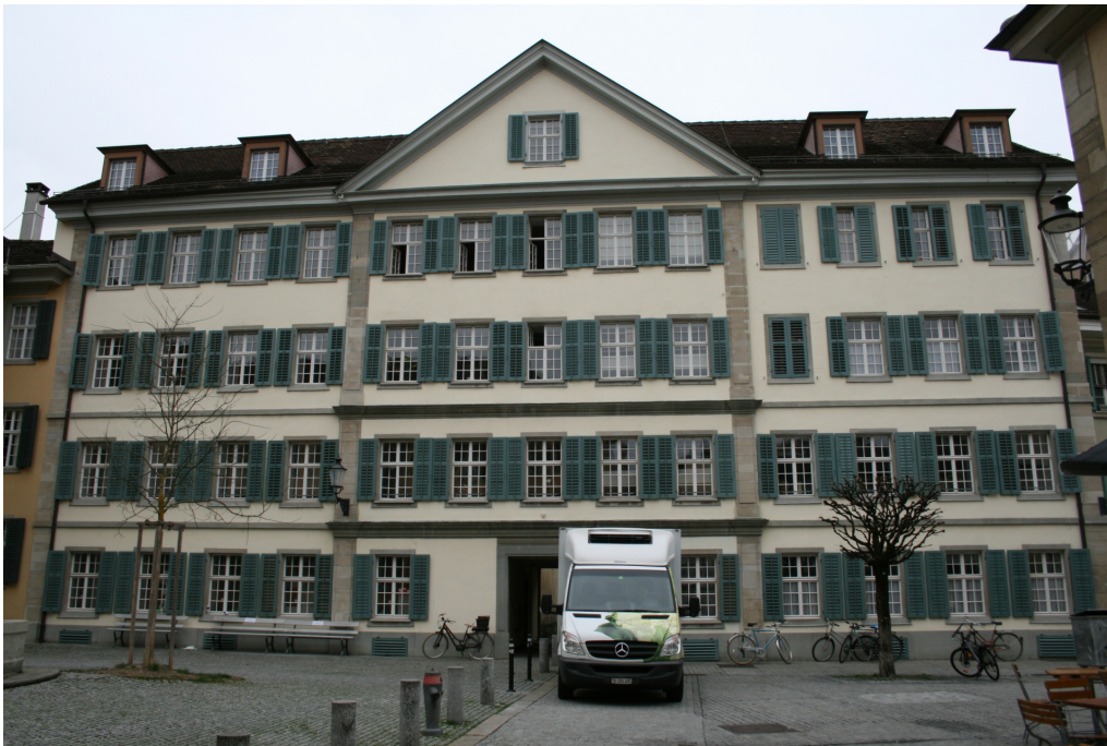
Alterswohnheim, ehem. «Oberer Spital», Ansicht von S, 21.03.2017 (Bild Nr. D101134_74).
