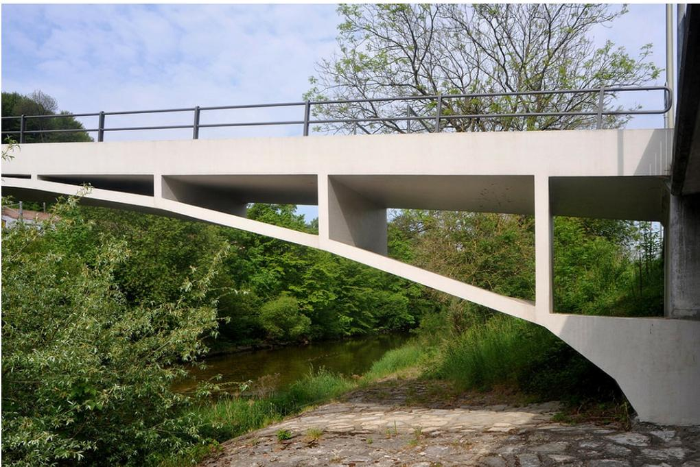
Betonbogensteg, Versteifungsbogen und nordwestliches Widerlager (Detail), Ansicht von SO, Bild: attention.ch. online-datenbank schweizer architektur, Stand 31.08.2016., 31.08.2016 (Bild Nr. D101120\_35).
