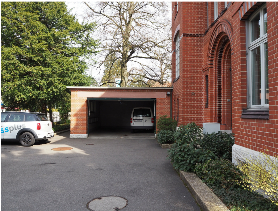
Villa Jung, Garage, Ansicht von W, 21.03.2017 (Bild Nr. D101127_71).
