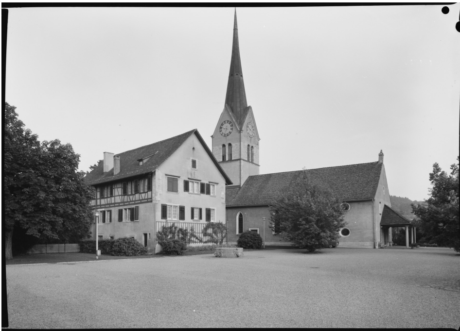
Ref. Pfarrhaus und ref. Kirche, Ansicht von NW, 13.08.1965 (Bild Nr. U26366).
