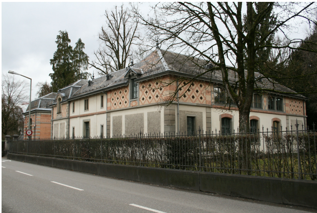
Ensemble Villa Bühler-Egg, Ökonomiegebäude (230ST00744), links hinten Orangerie- und Ateliergebäude (230ST01090), Ansicht von SO, 28.02.2017 (Bild Nr. D101135_67).
