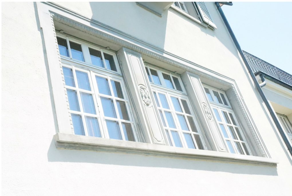
Klinik, ehem. Villenensemble Sulzer-Forrer, ehem. Wohnhaus (230ST02719), bauzeitliches Drillingsfenster mit bauzeitlichem, ornamentalen Sandsteingewände, 15.04.2014 (Bild Nr. D100626_03).
