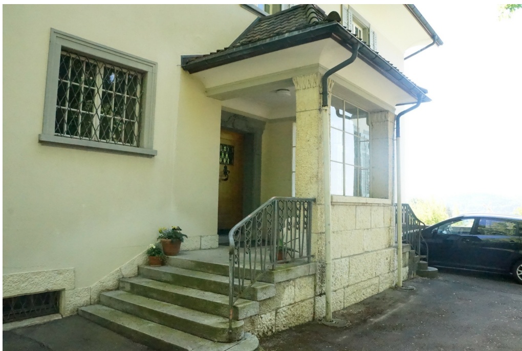
Klinik, ehem. Villenensemble Sulzer-Forrer, ehem. Wohnhaus (230ST02719), Portal an der Westfassade, Ansicht von N, 15.04.2014 (Bild Nr. D100626_05).
