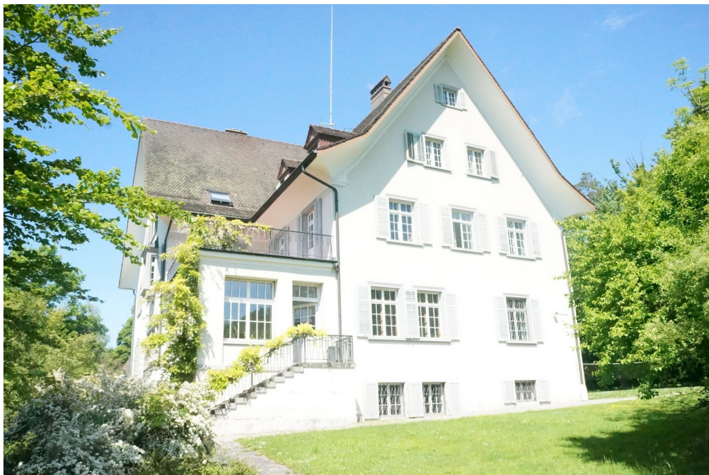
Klinik, ehem. Villenensemble Sulzer-Forrer, ehem. Wohnhaus (230ST02719), Ansicht von SO, 15.04.2014 (Bild Nr. D100626_01).
