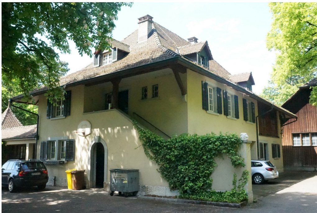
Klinik, ehem. Villenensemble Sulzer-Forrer, ehem. Wohn- und Ökonomiegebäude (230ST02728), Ansicht von O, 15.04.2014 (Bild Nr. D100626_06).
