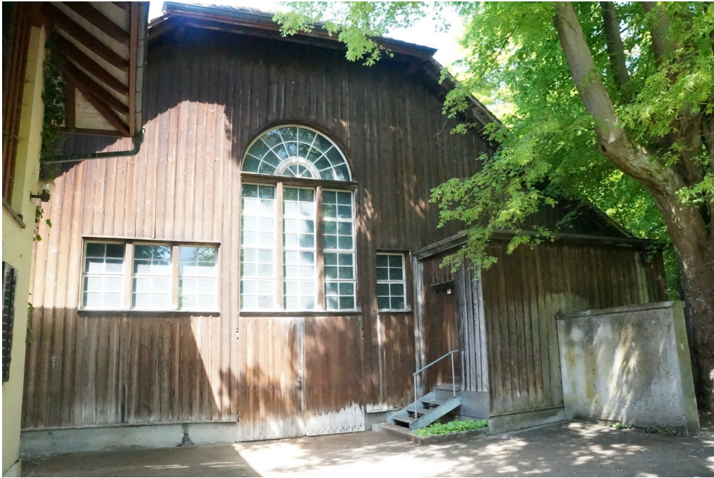
Klinik, ehem. Villenensemble Sulzer-Forrer, Reithalle (230ST04010), Ansicht von SO, 15.04.2014 (Bild Nr. D100626_14).
