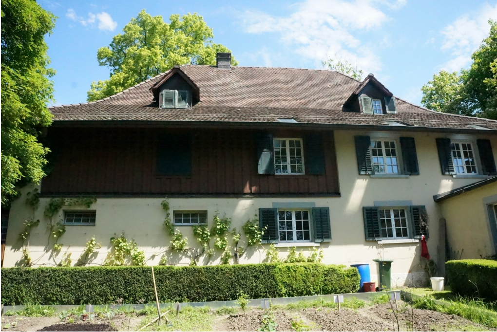
Klinik, ehem. Villenensemble Sulzer-Forrer, ehem. Wohn- und Ökonomiegebäude (230ST02728), Ansicht von SW, 15.04.2014 (Bild Nr. D100626_08).
