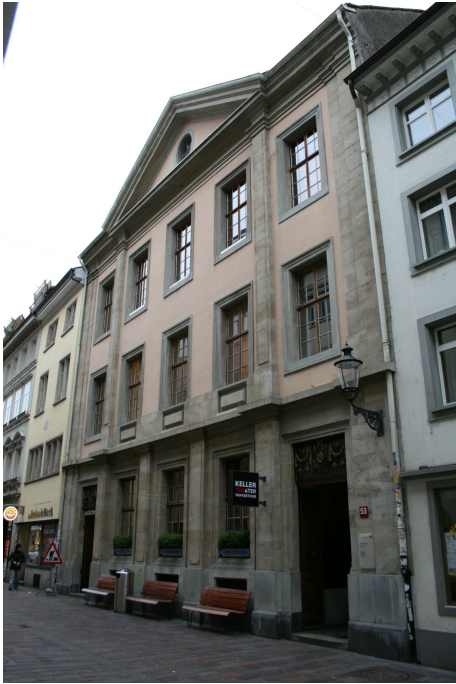
«Altes Stadthaus», ehem. Kranken- und Pfrundhaus, Ansicht von NW, 22.06.2017 (Bild Nr. D101134_72).
