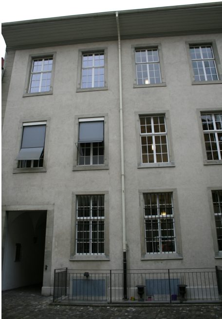
«Altes Stadthaus», ehem. Kranken- und Pfrundhaus, Ansicht von S, 22.06.2017 (Bild Nr. D101134_71).
