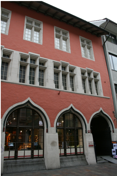
«Waaghaus», Ansicht von N, 21.03.2017 (Bild Nr. D101130_77).
