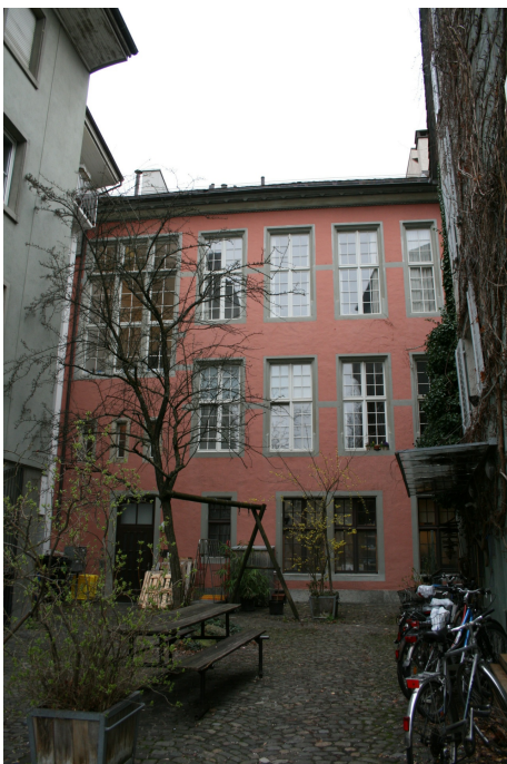
«Waaghaus», Ansicht von S, 21.03.2017 (Bild Nr. D101130_79).
