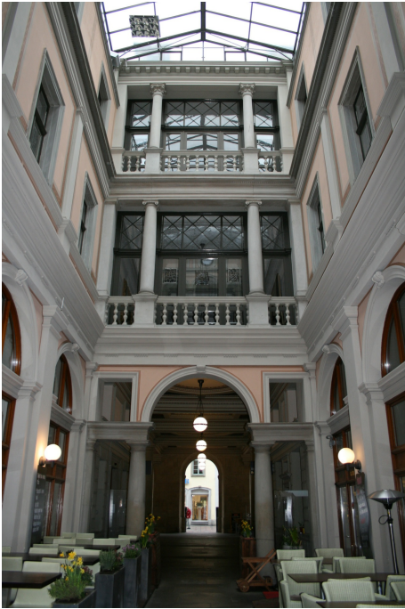
Rathaus, Innenhof, Ansicht von N, 21.03.2017 (Bild Nr. D101134_52).
