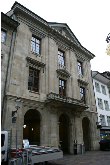
Rathaus, Ansicht von S, 21.03.2017 (Bild Nr. D101134_50).
