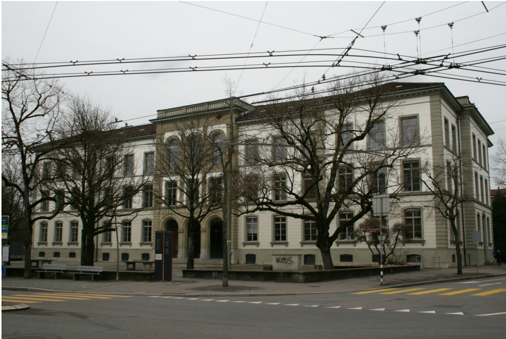
Schulhaus Altstadt, Ansicht von SO, 28.02.2017 (Bild Nr. D101134_02).
