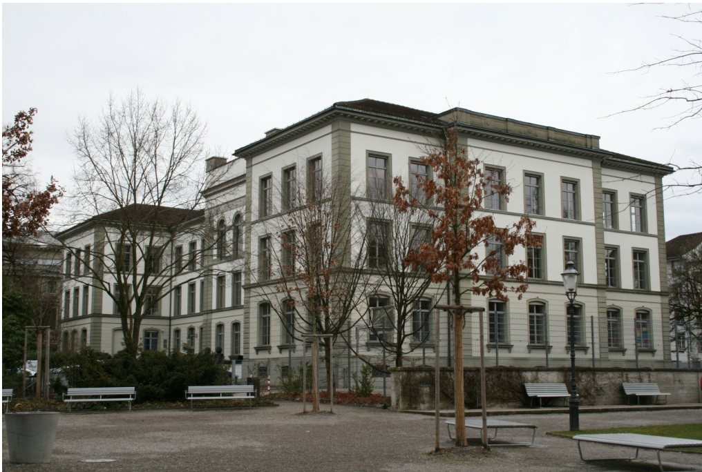
Schulhaus Altstadt, Ansicht von W, 28.02.2017 (Bild Nr. D101134_06).
