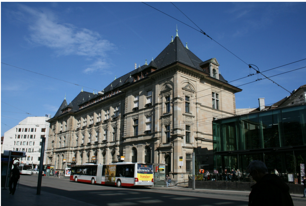
«Hauptpost», Ansicht von SW, 28.02.2017 (Bild Nr. D101127_91).
