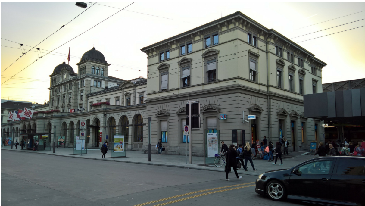
Bahnhof Winterthur, Aufnahmegebäude, erhöhter Kernbau, Vorhalle und rechts der nordöstliche Anbau, Ansicht von NO, 26.09.2016 (Bild Nr. D101113_39).
