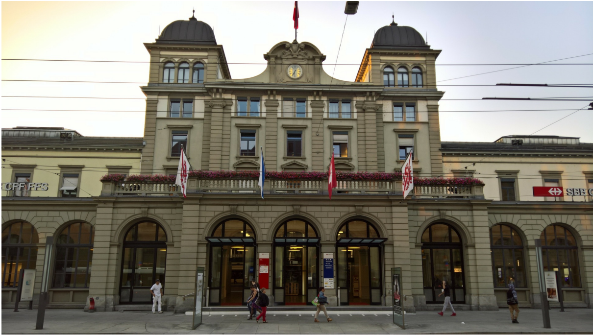
Bahnhof Winterthur, Aufnahmegebäude, erhöhter Kernbau mit Vorhalle, Ansicht von O, 26.09.2016 (Bild Nr. D101113_37).
