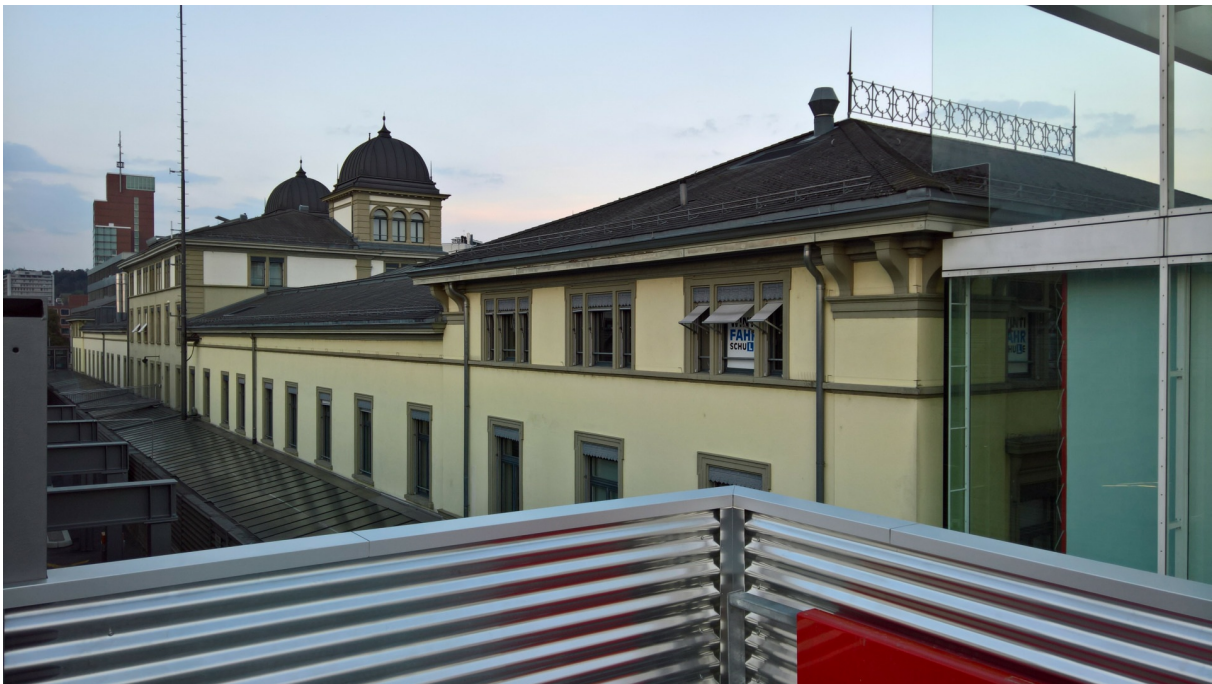
Bahnhof Winterthur, Aufnahmegebäude, Nordwestfassade über dem Parkdeck von 1987 (230ST00940), rechts die Gebäudeecke des «Stadttors» (230ST04440, nordöstlicher Teil) Ansicht von SW, 26.09.2016 (Bild Nr. D101113_51).
