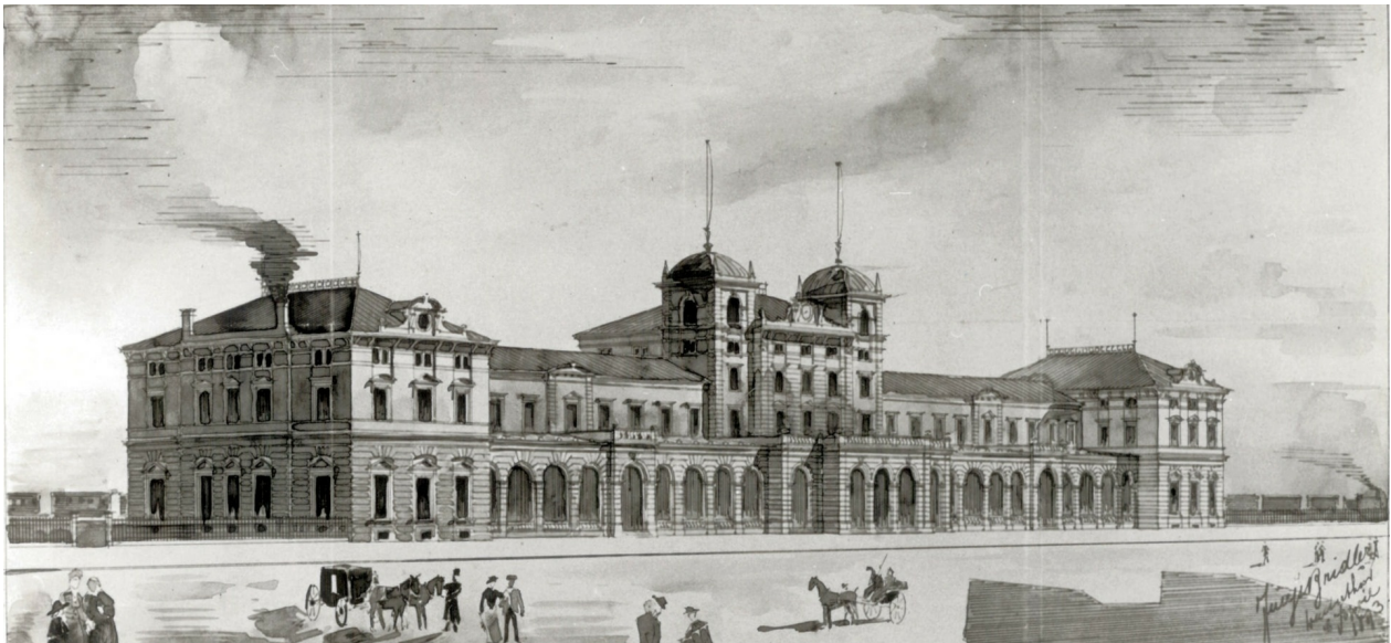
Bahnhof Winterthur, Aufnahmegebäude, Erweiterung 1894–1895, Ansicht von S, handlavierte Heliografie, signiert: «Jung & Bridler Winterthur, 1893, Bild: Stadtbibliothek Winterthur, 01.01.1893 (Bild Nr. D101113_33).
