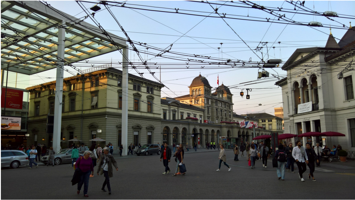
Bahnhof Winterthur, Aufnahmegebäude, Ansicht von S, links das «Stadttor» (Bahnhofplatz 5; 230ST04440, nordöstlicher Teil), 26.09.2016 (Bild Nr. D101113_35).
