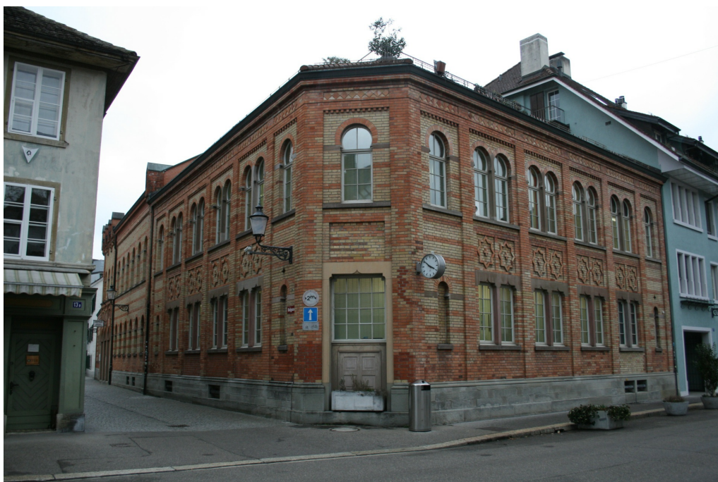
Ehem. Bade- und Waschanstalt, Ansicht von SO, 28.02.2017 (Bild Nr. D101128_30).
