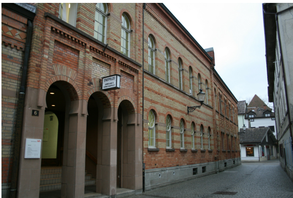
Ehem. Bade- und Waschanstalt, Ansicht von SW, 28.02.2017 (Bild Nr. D101128_32).
