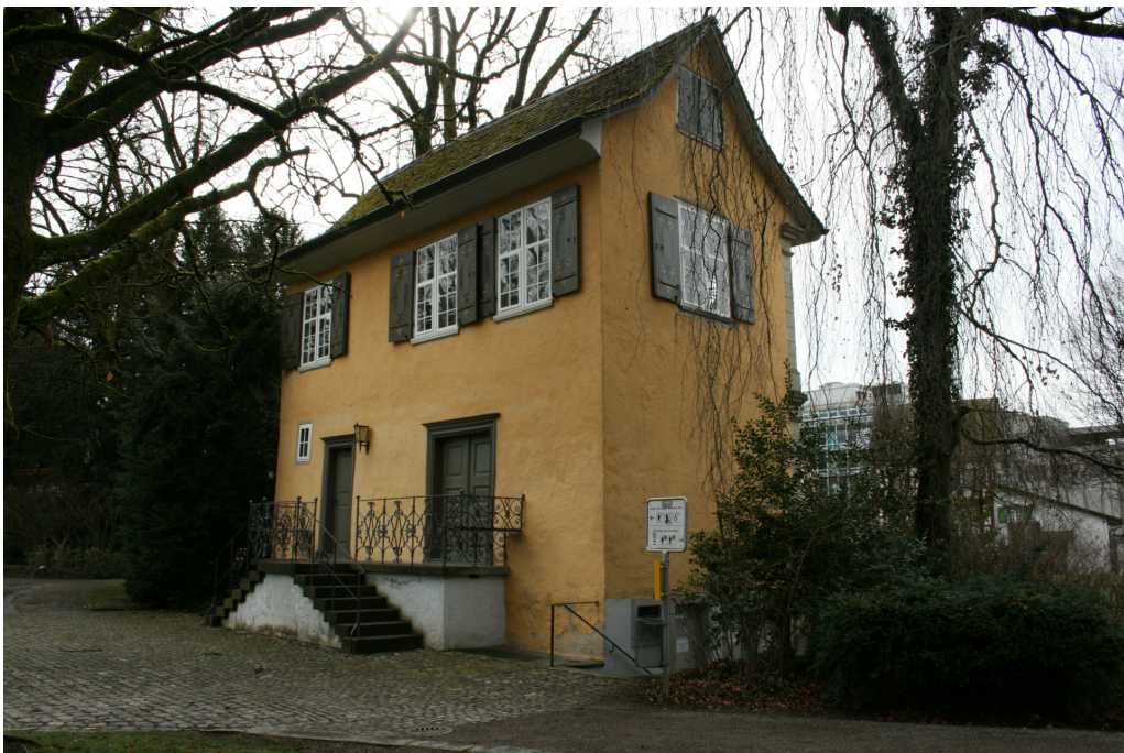
Ehem. Sommerhaus «Zum Balustergarten», Ansicht von NO, 28.02.2017 (Bild Nr. D100645_19).
