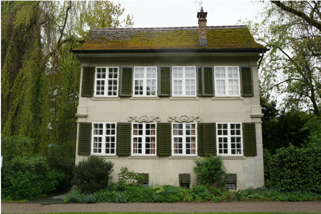
Ehem. Sommerhaus «Zum Balustergarten», Westfassade, 28.04.2014 (Bild Nr. D100645_14).
