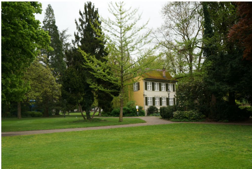
Ehem. Sommerhaus «Zum Balustergarten», Blick nach SO über den Stadtgarten zum ehem. Sommerhaus «Zum Balustergarten» (230ST00531), 28.04.2014 (Bild Nr. D100645_17).
