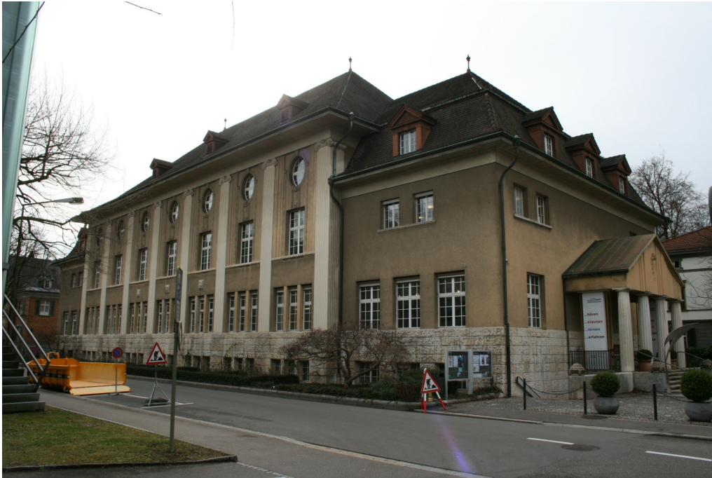
Ref. Kirchgemeindehaus, Ansicht von NO, 06.04.2017 (Bild Nr. D101130_64).
