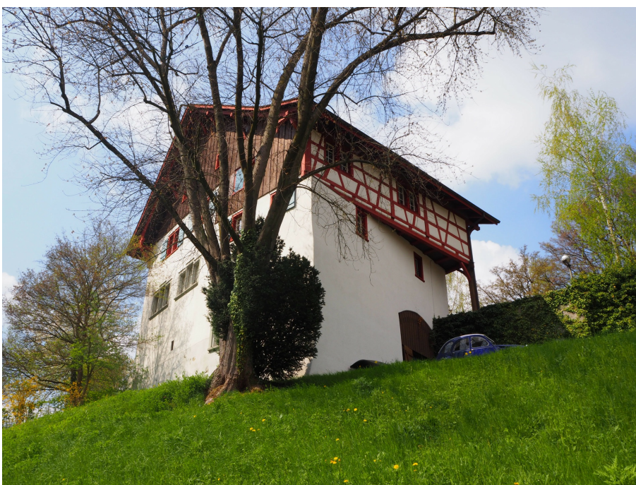
«Hohlandhaus», Ansicht von SO, 01.04.2017 (Bild Nr. D101130_13).
