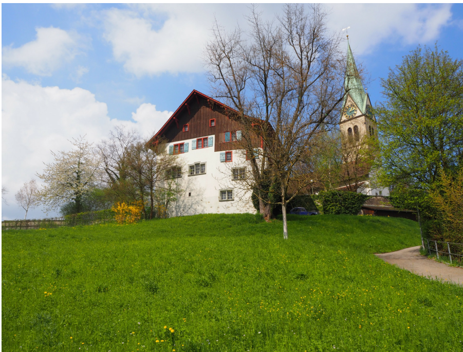
«Hohlandhaus», Ansicht von S, 01.04.2017 (Bild Nr. D101130_15).
