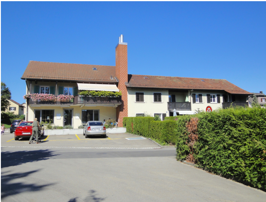
Siedlung Grabenacker, Häuserreihe mit Ladenlokal (Grabenackerstrasse 32, 34, 36; 230OB02315), Ansicht von S, 29.10.2013 (Bild Nr. D101125_64).
