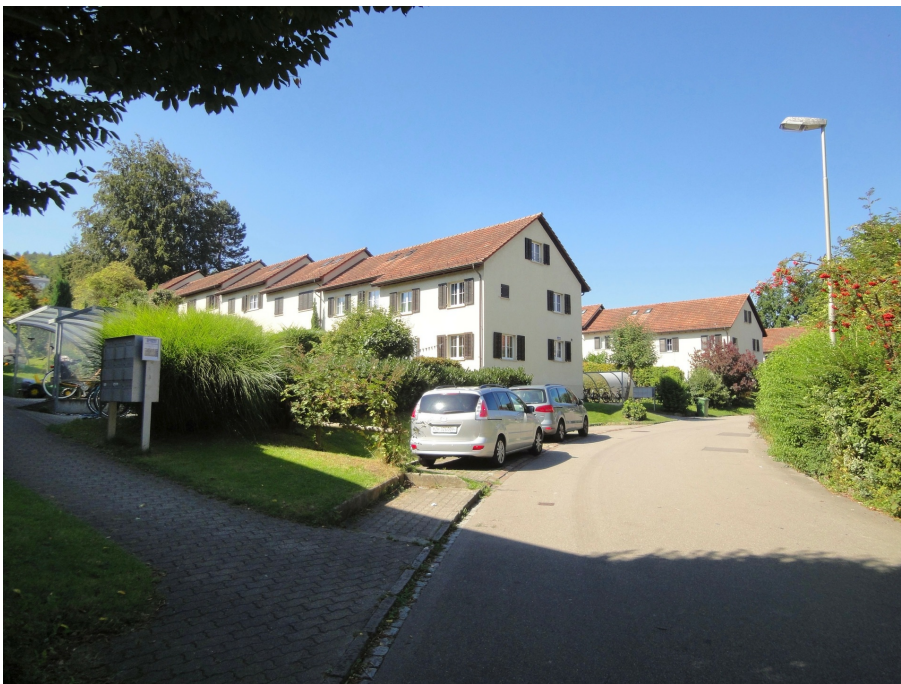
Siedlung Grabenacker, Reihenhäuser (in der Bildmitte Grabenackerstrasse 43; 230OB02236), Ansicht von SO, 28.10.2013 (Bild Nr. D101358_23).
