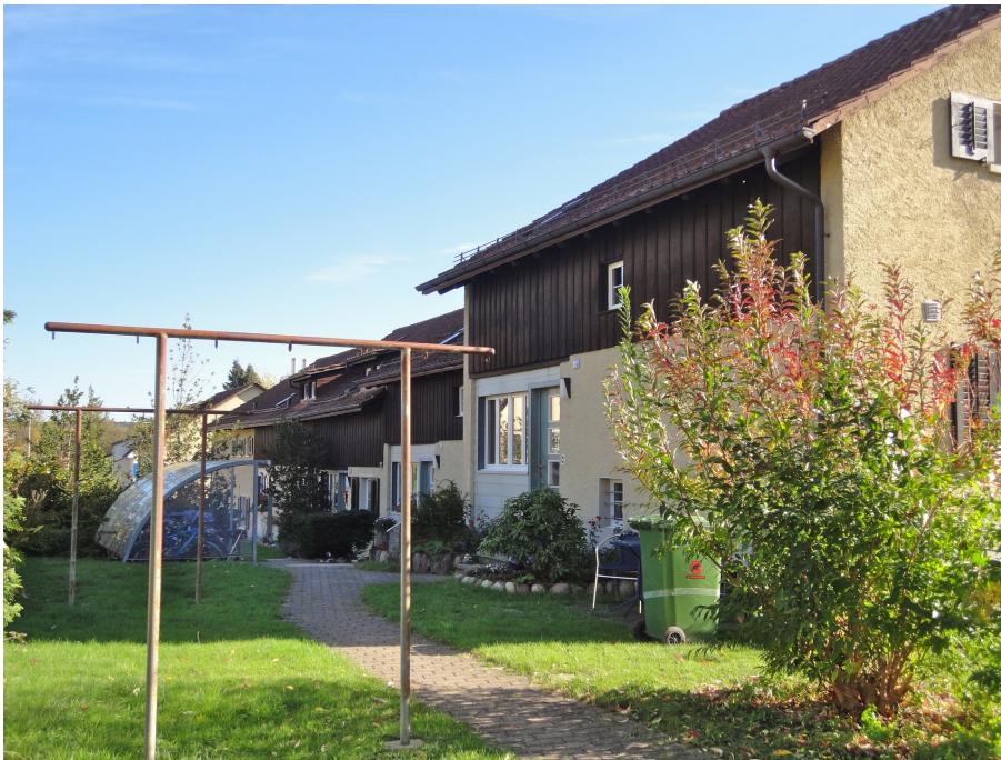
Siedlung Grabenacker, Reihenhäuser (rechts Grabenackerstrasse 103; 230OB02290), Nordfassaden mit Holzverschalungen, im Garten bauzeitliche Wäschestangen, Ansicht von NW, 29.10.2013 (Bild Nr. D101125_66).
