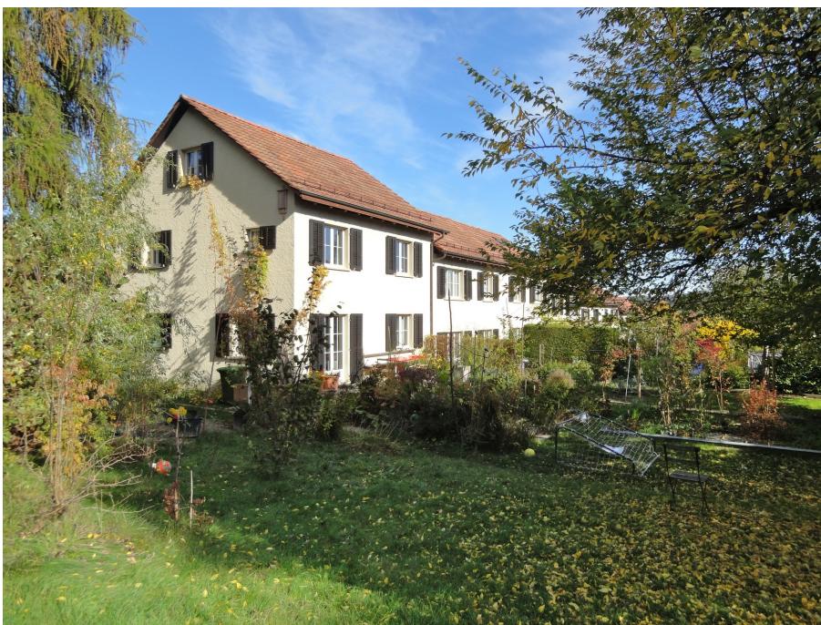
Siedlung Grabenacker, Reihenhäuser (links Grabenackerstrasse 41; 230OB02227), Ansicht von SW, 28.10.2013 (Bild Nr. D101358_22).
