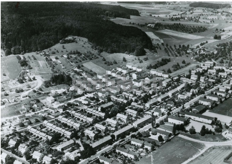
Siedlung Grabenacker, Luftbild von SO, um 1960, Bild: Stadtbibliothek Winterthur, 01.01.1960 (Bild Nr. D101125_61).
