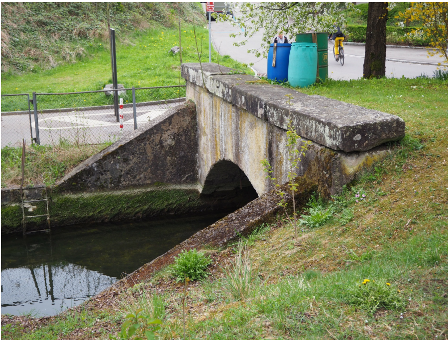
Wasserkraftanlage Rieter, Wasserkraftanlage Niedertöss (230TOWR01219-5), Kanal entlang der Töss ganz im S, Portal der Kanalüberdeckung bei der J.-C.-Heer-Strasse, 05.04.2017 (Bild Nr. D101120_79).
