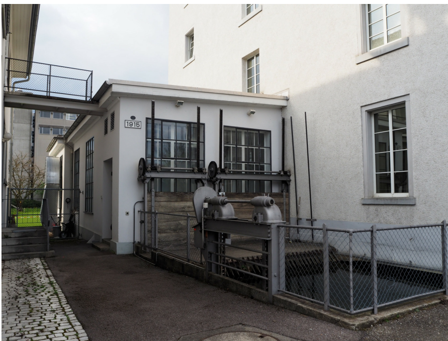
Wasserkraftanlage Rieter, Werkareal Niedertöss (230TO00671) und Wasserkraftanlage Niedertöss (230TOWR01219-5), Ansicht von S, 05.04.2017 (Bild Nr. D101120_68).
