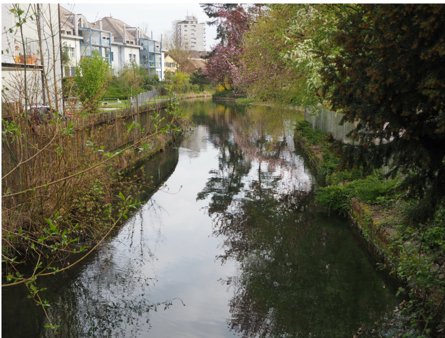
Wasserkraftanlage Rieter, Wasserkraftanlage Niedertöss (230TOWR01219-5), Kanal mit Rückstaubecken, 05.04.2017 (Bild Nr. D101120_72).
