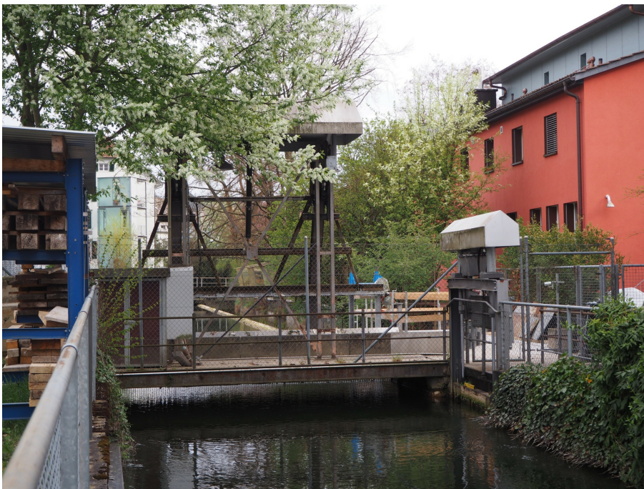
Wasserkraftanlage Rieter, Wasserkraftanlage Niedertöss (230TOWR01219-5), Kanal mit Fussgängerüberführung und Wehr, 05.04.2017 (Bild Nr. D101120_69).
