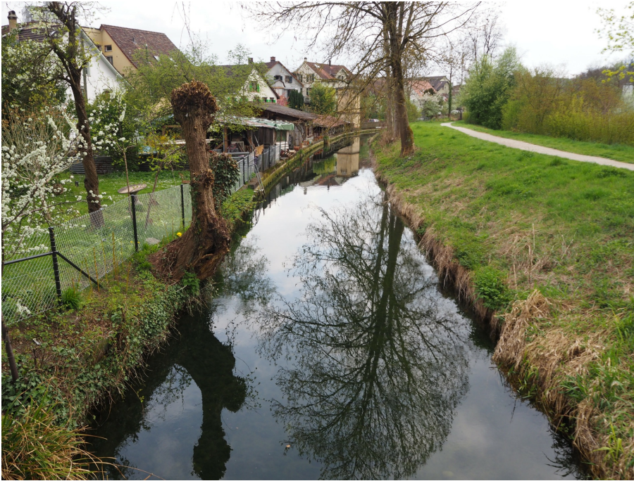
Wasserkraftanlage Rieter, Wasserkraftanlage Niedertöss (230TOWR01219-5), Kanal entlang der Töss, 05.04.2017 (Bild Nr. D101120_76).
