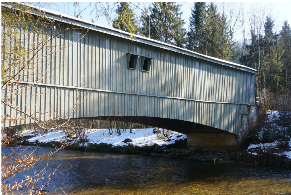
Holzbrücke, ehem. «Brunibrücke», Ansicht von NW, 25.02.2015 (Bild Nr. D101065_04).
