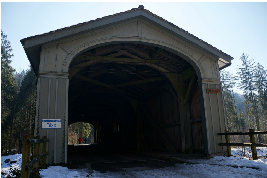
Holzbrücke, ehem. «Brunibrücke», nördliche Giebelseite, 25.02.2015 (Bild Nr. D101065_06).
