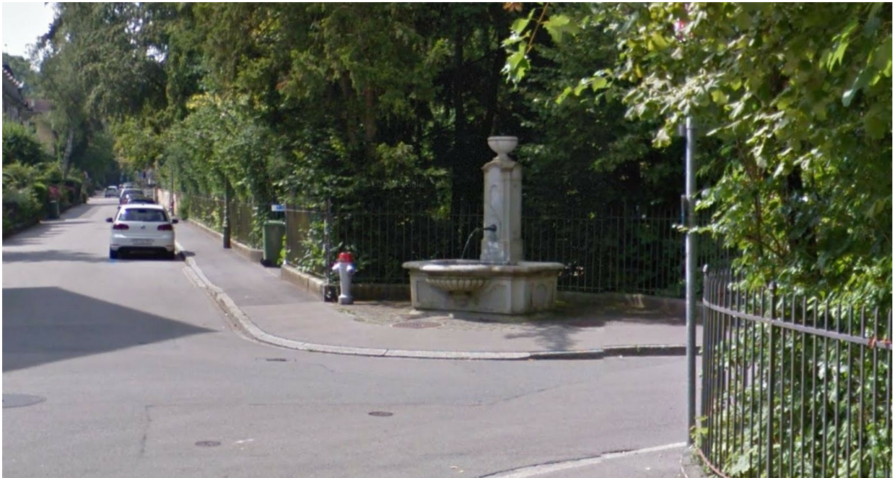
Ensemble Villa «Trollegg», Brunnen (230STBRUNNEN02107), Ansicht von NO, 28.02.2017 (Bild Nr. D101135_83).
