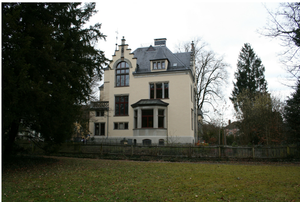
Ensemble Villa «Trollegg», Villa Bühler-Koller (230ST02107), Ansicht von W, 28.02.2017 (Bild Nr. D101135_81).
