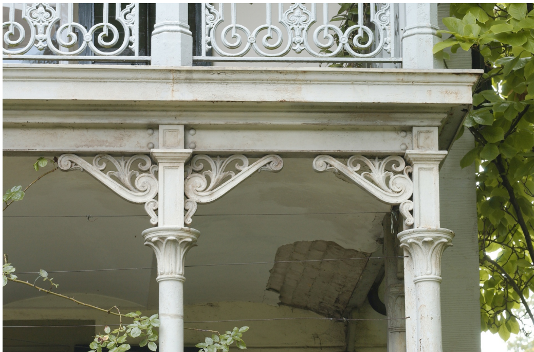
Landsitz «Rosenberg», Ensemble ehem. Villa Bidermann, ehem. Villa Bidermann (230ST00551), Veranda auf der Südwestseite (Detail), 04.09.2001 (Bild Nr. D100212_31).
