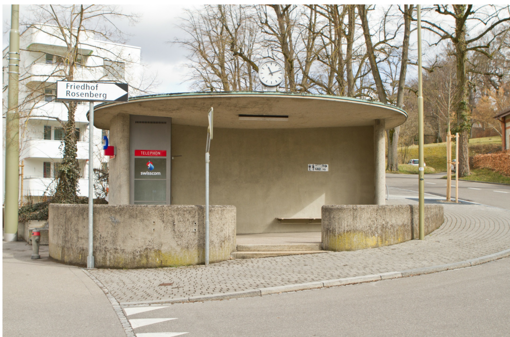
Buswartehäuschen Rosenberg, Ansicht von S, 21.03.2013 (Bild Nr. D101137_12).
