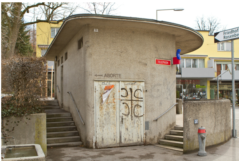
Buswartehäuschen Rosenberg, Ansicht von W, 21.03.2013 (Bild Nr. D101137_11).
