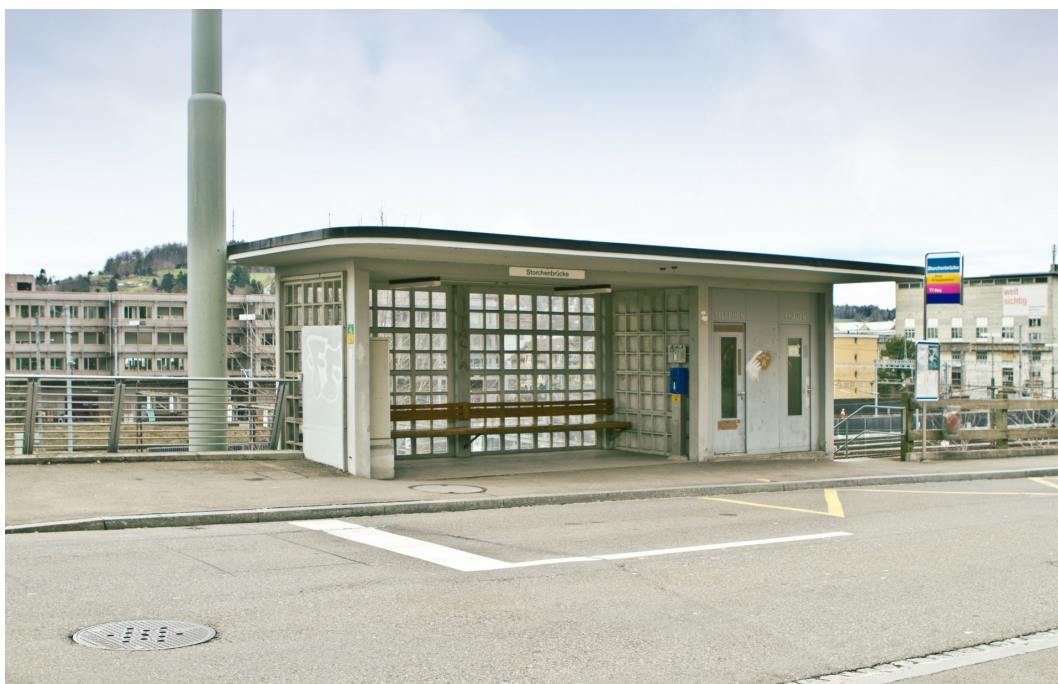
Buswartehäuschen Storchenbrücke, Ansicht von SO, 19.03.2013 (Bild Nr. D101137_21).
