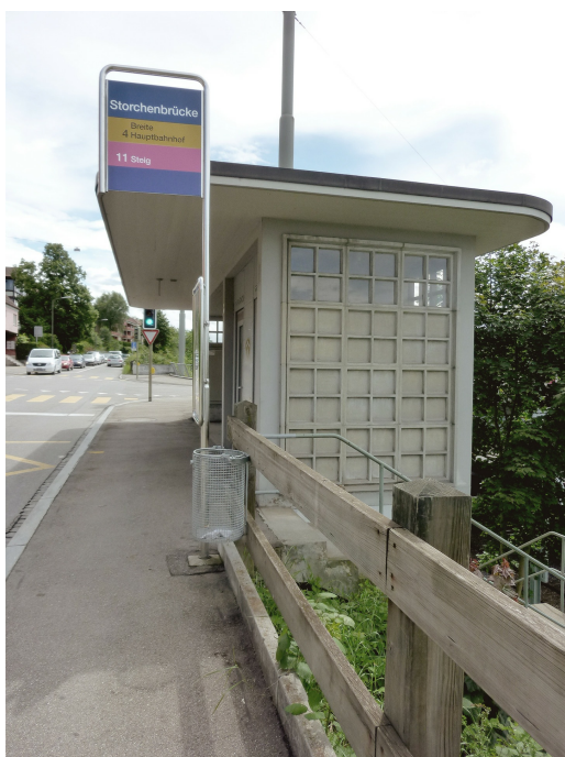
Buswartehäuschen Storchenbrücke, Ansicht von NO, 21.03.2013 (Bild Nr. D101137_24).
