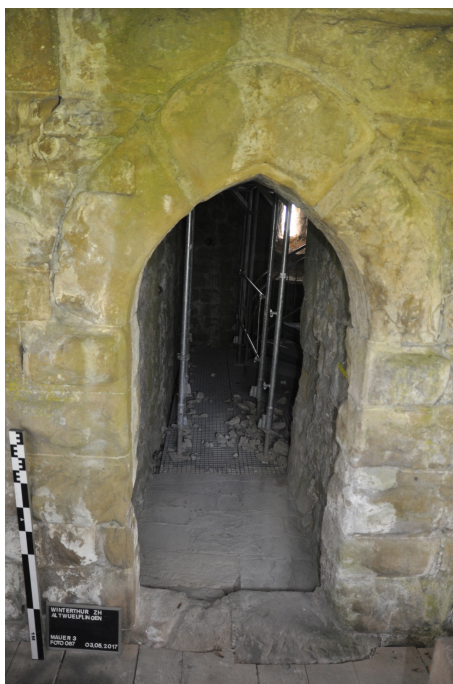
Burgruine Alt-Wülflingen, Nordostfassade, Hocheingang mit Spitzbogen, 01.01.2017 (Bild Nr. D101137_32).
