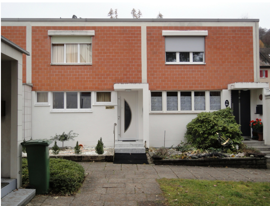
Siedlung Nägelsee, Nordost- bzw. Nordwestfassaden, links mit bauzeitlicher Befensterung (vorne rechts 230TO01708), 21.11.2016 (Bild Nr. D101133_75).
