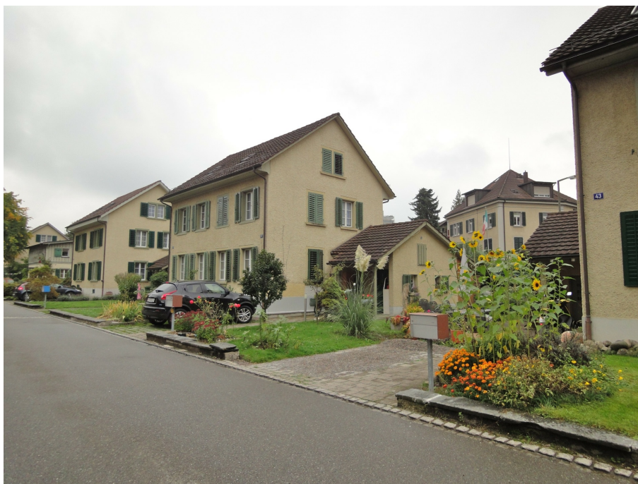
«Rieter-Siedlung», südwestlicher Teil der Siedlung, Blick von der Rieterstrasse Richtung SO, 09.10.2013 (Bild Nr. D101133_62).
