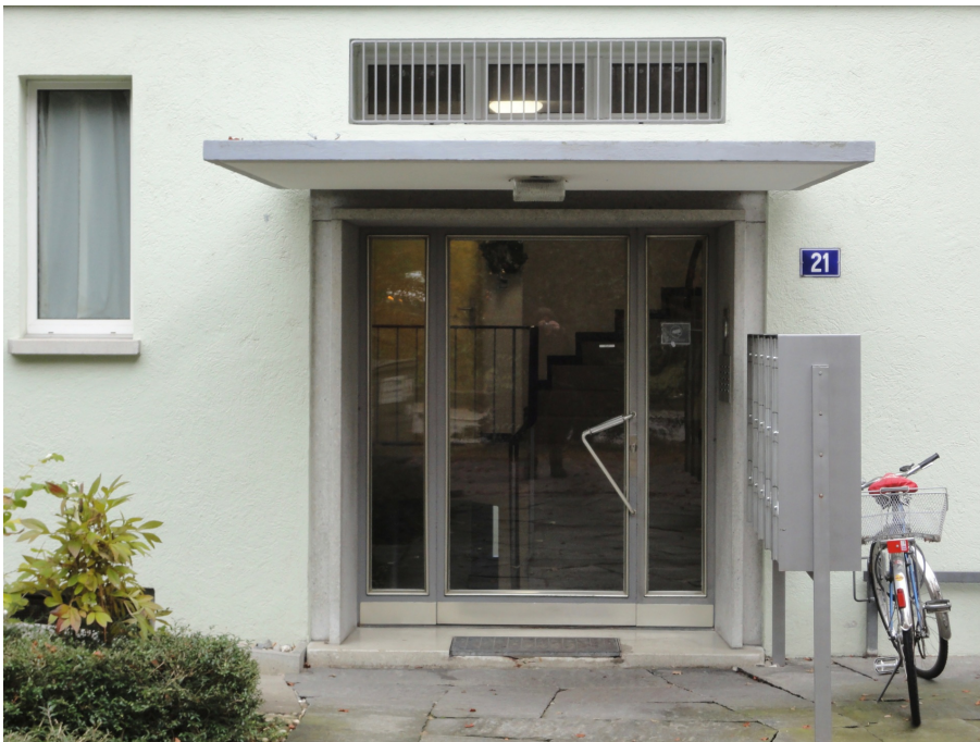
Wohnüberbauung «Brunnergut», bauzeitlicher Hauseingang (230ST05989), 21.11.2016 (Bild Nr. D101133_55).
