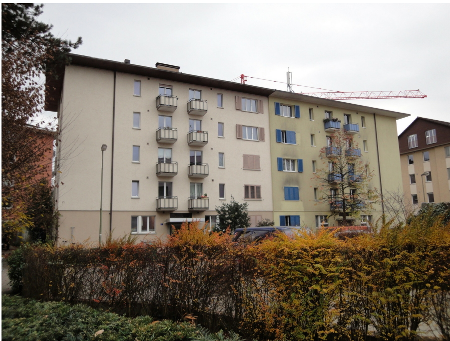
Wohnüberbauung «Brunnergut», Strassenfassaden Kreuzstrasse (230ST05993, 230ST05994), 21.11.2016 (Bild Nr. D101133_52).
