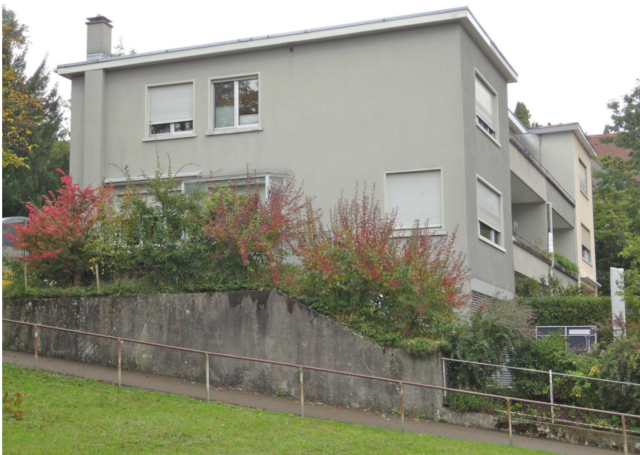
Reihenhäuser Brühlberg- und Mythenstrasse, Häuser an der Brühlbergstrasse (vorne links 230ST04513), Ansicht von S, 09.10.2013 (Bild Nr. D101133_44).
