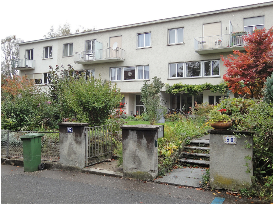
Reihenhäuser Brühlberg- und Mythenstrasse, Häuser an der Mythenstrasse (vorne links 230ST04455), Ansicht von O, 09.10.2013 (Bild Nr. D101133_45).
