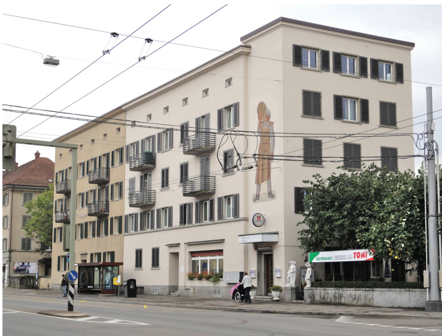
Siedlung «Schöntal III», Kopfbauten an der Zürcherstrasse, Ansicht von W (vorne rechts 230ST04410), 09.10.2013 (Bild Nr. D101133_20).
