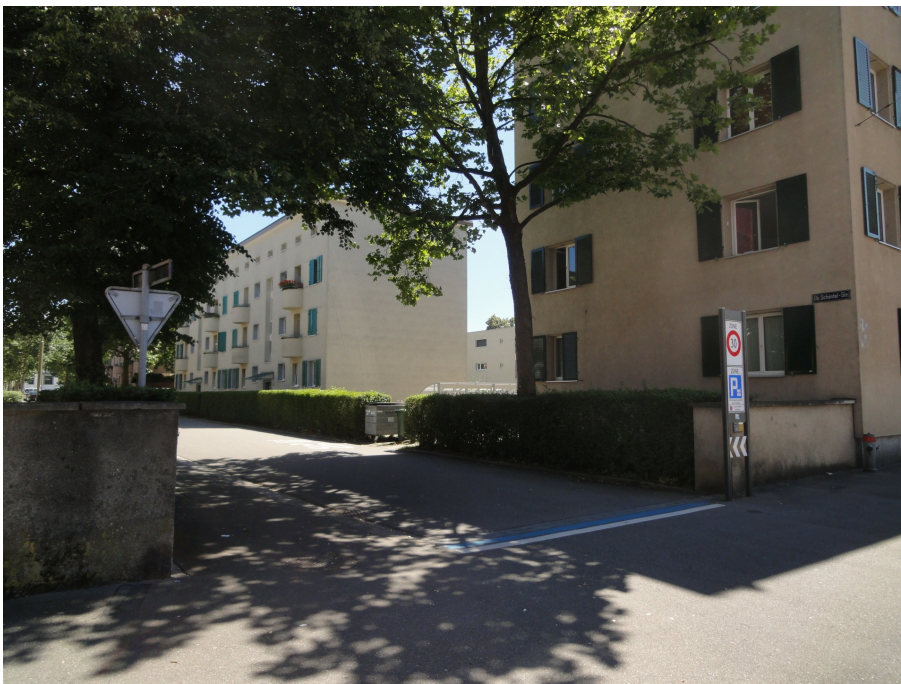
Siedlung «Schöntal III», Mauerscheiben als Siedlungseingang Obere Schöntalstrasse/Zürcherstrasse, Ansicht von N, 20.07.2016 (Bild Nr. D101133_26).
