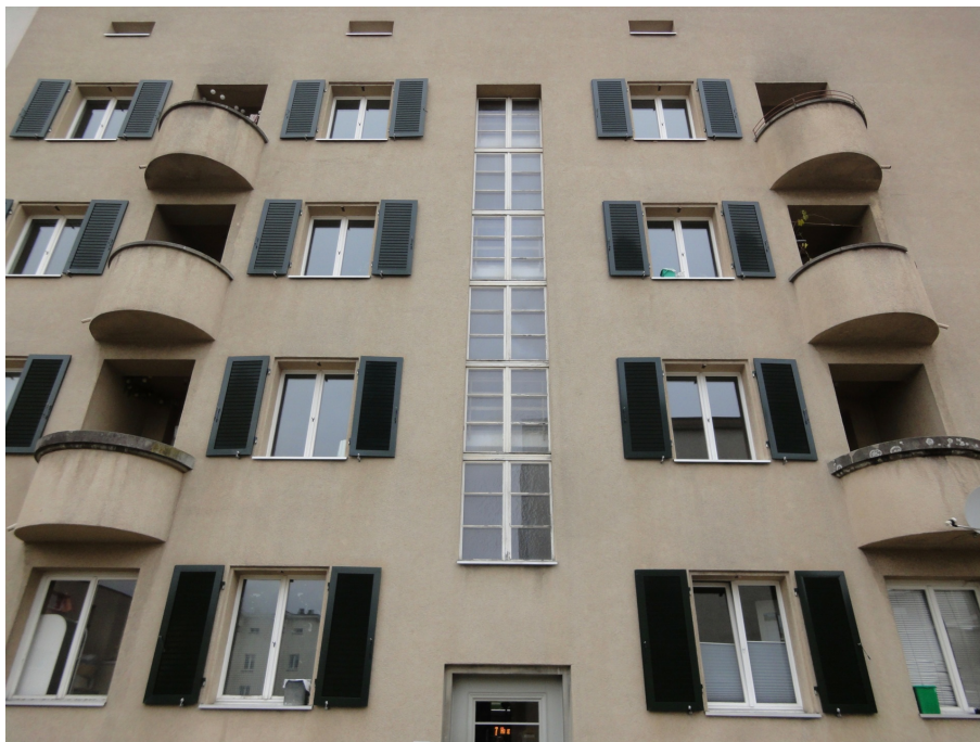
Siedlung «Schöntal III», Kopfbau an der Zürcherstrasse (230ST04409), Hoffassade, 21.11.2016 (Bild Nr. D101133_22).
