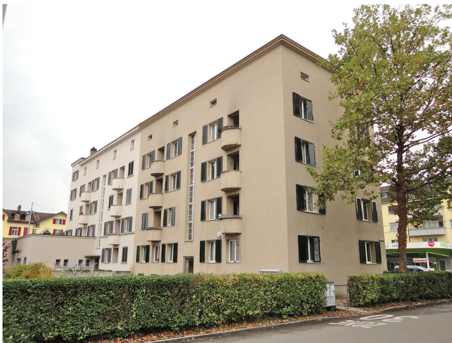
Siedlung «Schöntal III», Kopfbauten an der Zürcherstrasse, Ansicht von O (vorne rechts 230ST04409), 09.10.2013 (Bild Nr. D101133_21).
