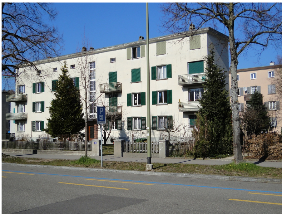
Siedlung «Schöntal III», Block Briggerstrasse von S (vorne rechts 230ST04586), 17.03.2016 (Bild Nr. D101133_23).
