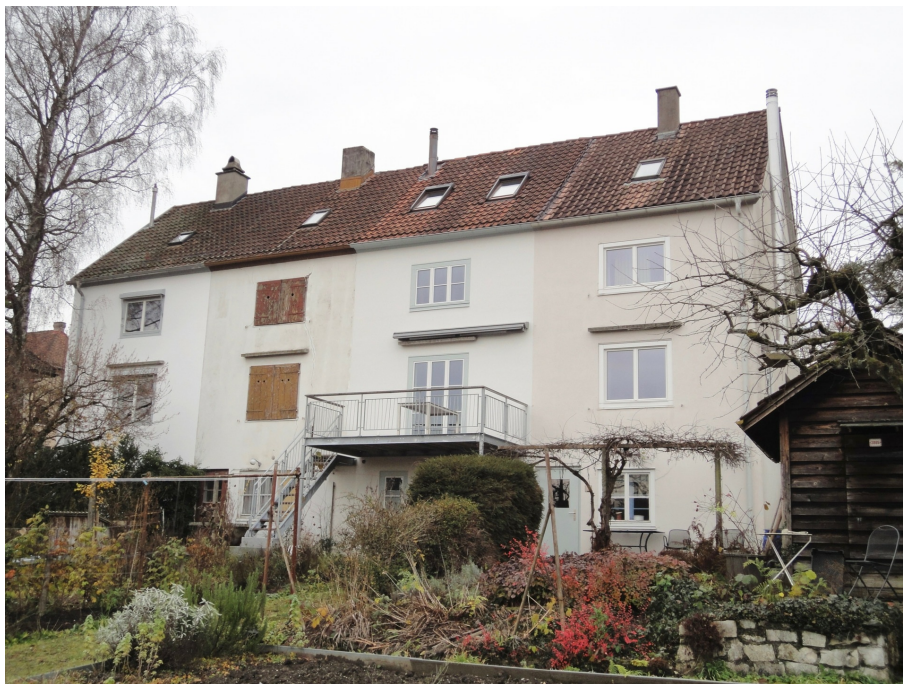
«Scheibler-Häuser» im Vogelsang, Nordwestfassaden (vorne rechts 230ST03471), mit bauzeitlich erhaltenem Haus (zweites von links, 230ST03469), 25.11.2016 (Bild Nr. D101133_05).
