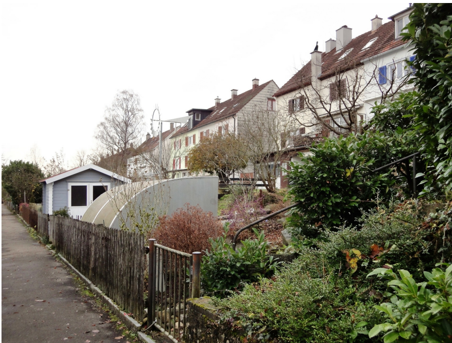
«Scheibler-Häuser» im Vogelsang, Ansicht von W (vorne rechts 230ST03681), 25.11.2016 (Bild Nr. D101133_03).
