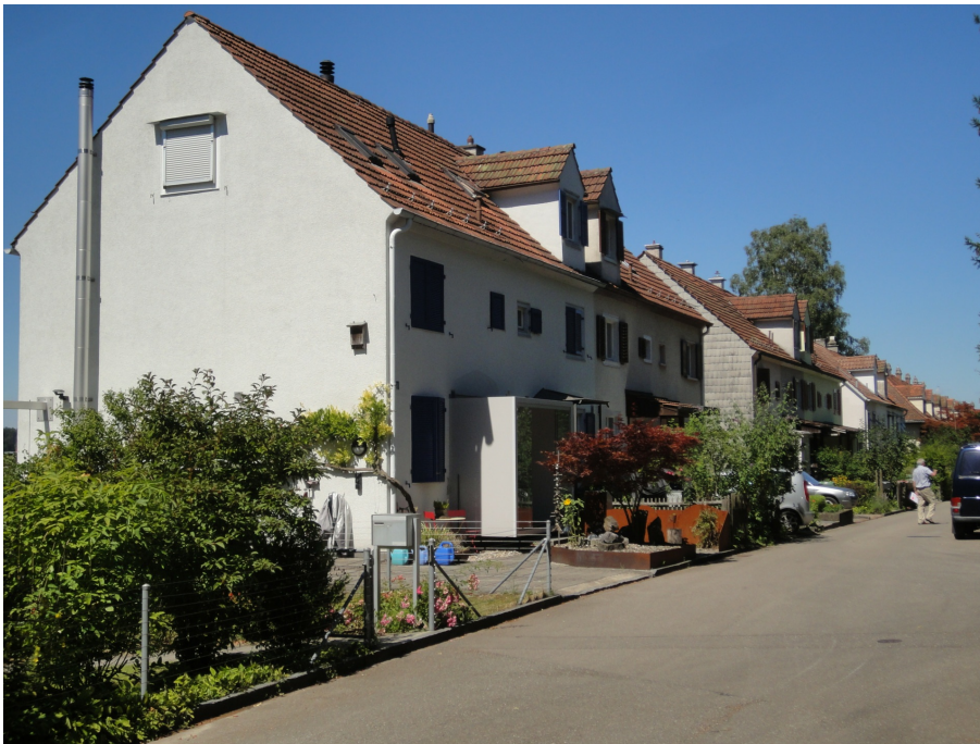
«Scheibler-Häuser» im Vogelsang, Vorgärten an der Jonas-Furrer-Strasse, Ansicht von S, 25.11.2016 (Bild Nr. D101133_09).
