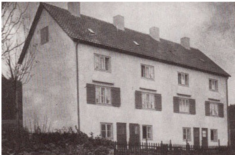
«Scheibler-Häuser» im Vogelsang, Wohnhaus (230ST03468), Aufnahme um 1925, Bild: Werk, 1925, Nr. 1, S. 76), 01.01.1925 (Bild Nr. D101133_01).
