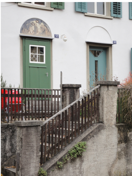
Städtische Wohnkolonie im Vogelsang, Lünettenmalerei Südostfassade (links 230ST03306), 25.11.2016 (Bild Nr. D101126_86).
