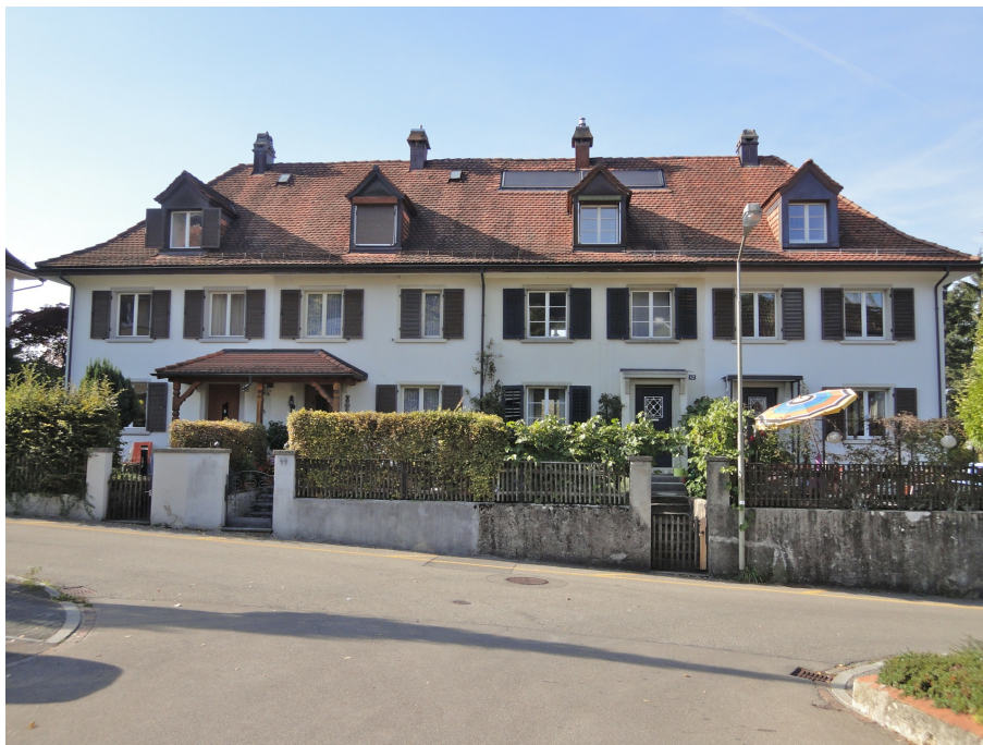
Städtische Wohnkolonie im Vogelsang, nordöstlichster Block (rechts aussen 230ST03311), Südostfassaden, 25.09.2013 (Bild Nr. D101126_83).
