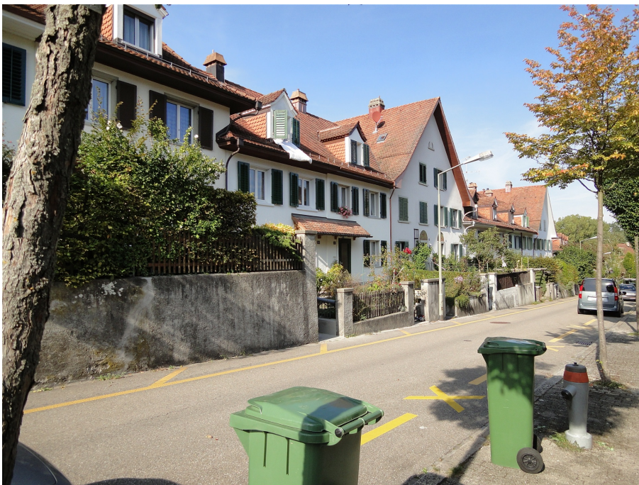
Städtische Wohnkolonie im Vogelsang, mittlere Häuserreihe (vorne links 230ST03297), Ansicht von S, 25.09.2013 (Bild Nr. D101126_85).
