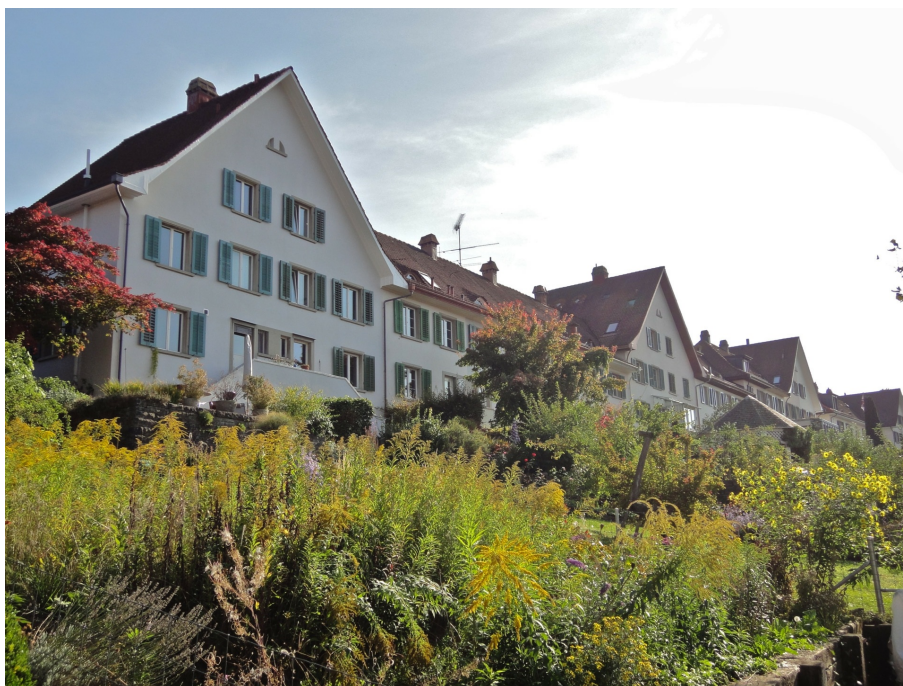
Städtische Wohnkolonie im Vogelsang, mittlere Häuserreihe (vorne links 230ST03307), Ansicht von N, 25.09.2013 (Bild Nr. D101126_84).
