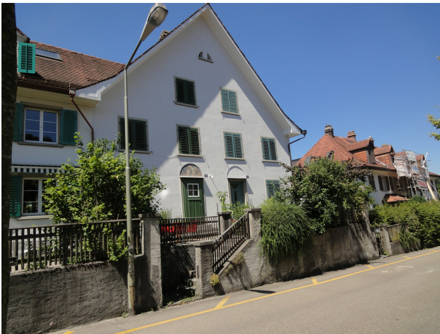
Städtische Wohnkolonie im Vogelsang, Vorgarten an der Jonas-Furrer-Strasse 48, Ansicht von W, 19.07.2016 (Bild Nr. D101126_89).
