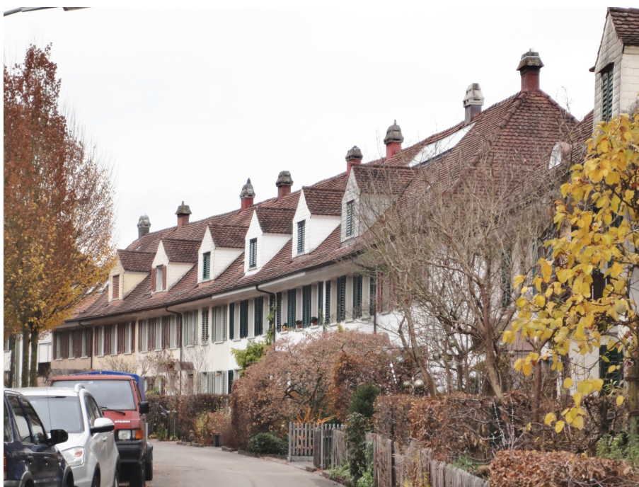
Siedlung Jonas-Furrer-Strasse, mittlere Häuserreihe, Ansicht von O (vorne rechts 230ST03214), 25.11.2016 (Bild Nr. D101126_64).
