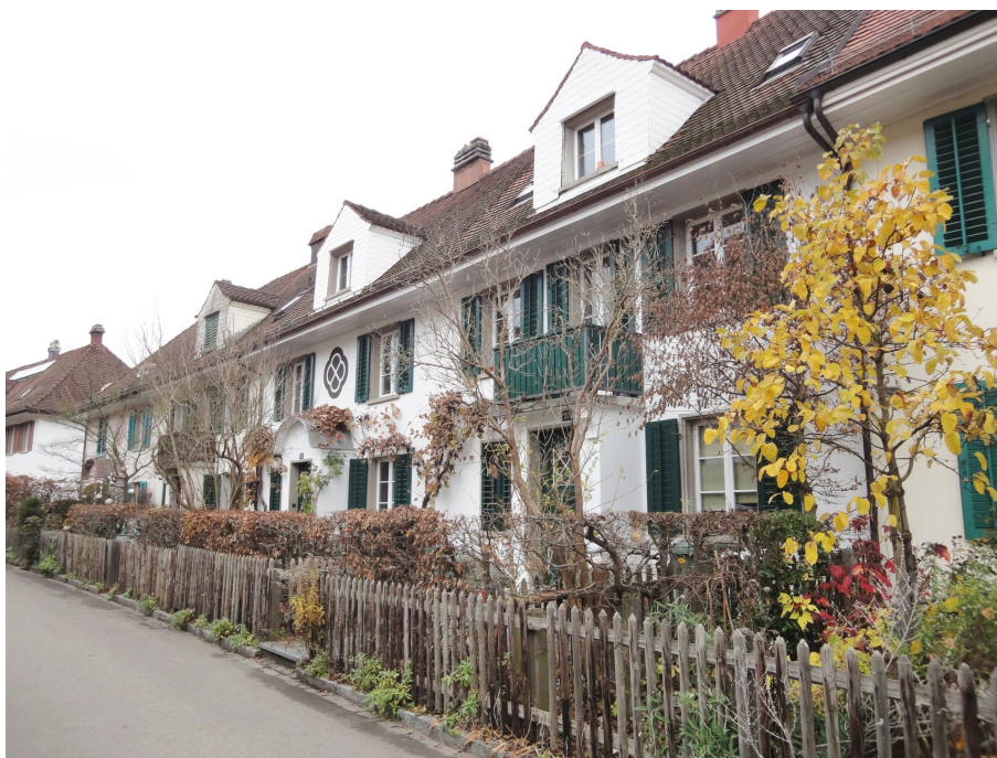
Siedlung Jonas-Furrer-Strasse, Häuserreihe Nord, Ansicht von O (vorne rechts 230ST03210), 25.11.2016 (Bild Nr. D101126_63).
