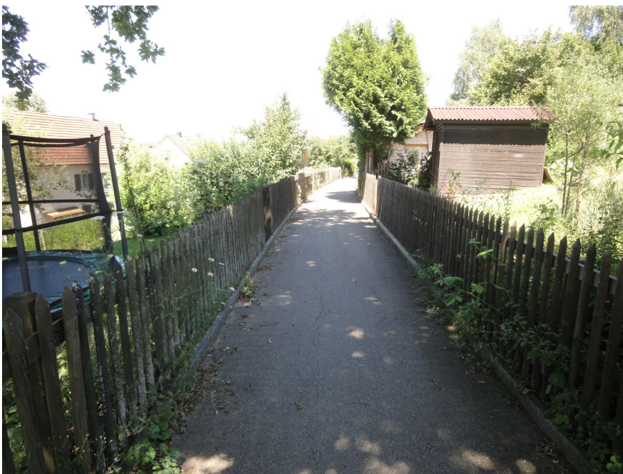
Siedlung Jonas-Furrer-Strasse, innerer Erschliessungsweg, Ansicht von SW, 19.07.2016 (Bild Nr. D101126_72).
