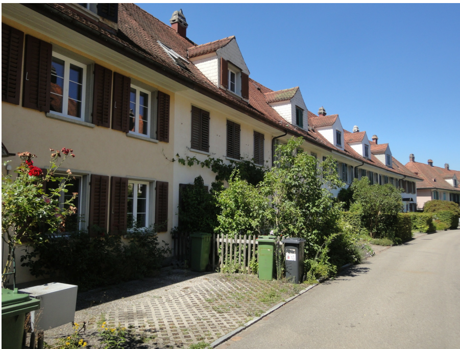
Siedlung Jonas-Furrer-Strasse, Häuser entlang der Jonas-Furrer-Strasse, 19.07.2016 (Bild Nr. D101126_69).
