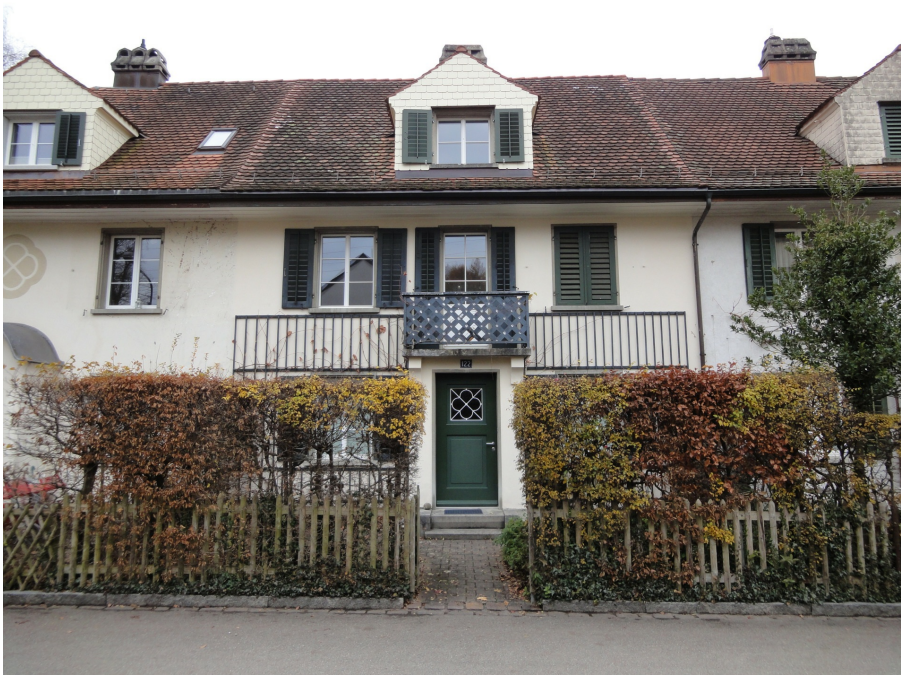
Siedlung Jonas-Furrer-Strasse, Häuserreihe Süd, Südostfassade mit Spaliergittern und bauzeitlichem Balkongeländer (230ST03226), 25.11.2016 (Bild Nr. D101126_67).
