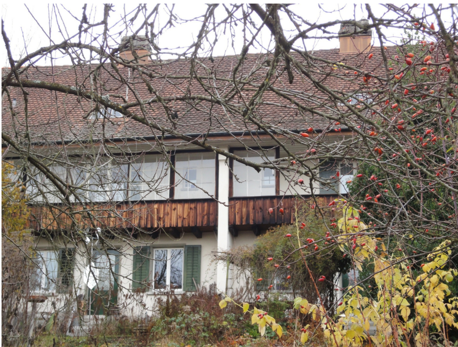
Siedlung Jonas-Furrer-Strasse, Häuserreihe Süd, Nordwestfassade mit Lauben (230ST03224, 230ST03225), 25.11.2016 (Bild Nr. D101126_68).
