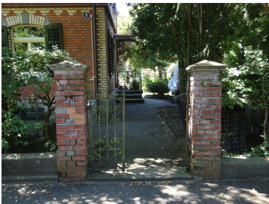
«Brauerquartier», Hauszugang mit Bordürensteinen an der Malzstrasse 9, Ansicht von O, 20.07.2016 (Bild Nr. D101126_28).
