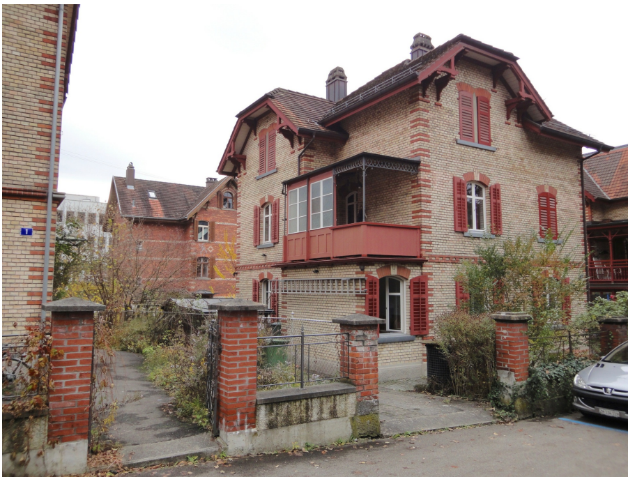
«Brauerquartier», abwechslungsreiche Detailformen (230ST02342), 21.11.2016 (Bild Nr. D101126_23).
