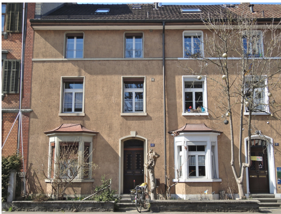
«Sulzer-Häuser», Südostfassaden mit bauzeitlichen Türblättern (links 230ST01032), 18.03.2016 (Bild Nr. D101126_06).
