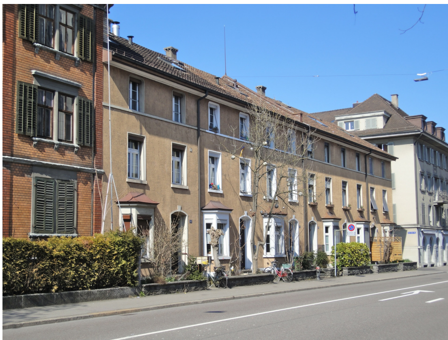
«Sulzer-Häuser», Ansicht von S (vorne links 230ST01032), 18.03.2016 (Bild Nr. D101126_02).
