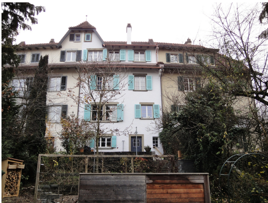
Siedlung Heiligberg II, Nordfassaden, rechter Teil (vorne rechts 230ST02575), 25.11.2016 (Bild Nr. D101125_84).
