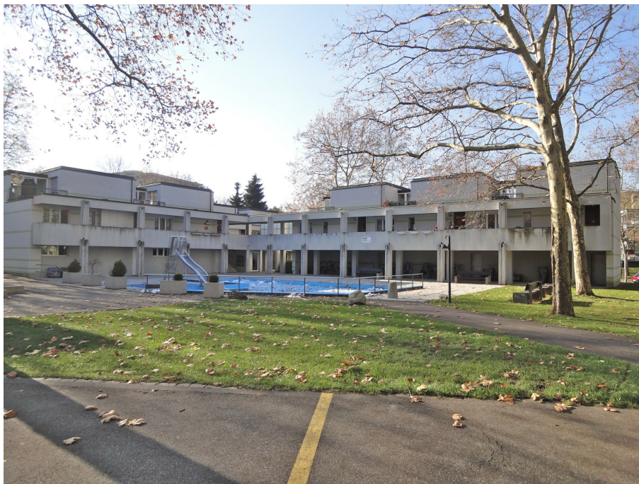
Überbauung Grüzefeld, Maisonette-Wohnungen (230MA07324), Ansicht von NO, 29.11.2013 (Bild Nr. D101125_55).
