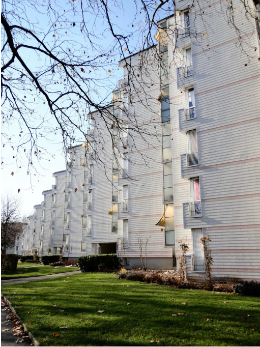
Überbauung Grüzefeld, gestaffelte Fassadenflucht (230MA07259), 29.11.2013 (Bild Nr. D101125_57).
