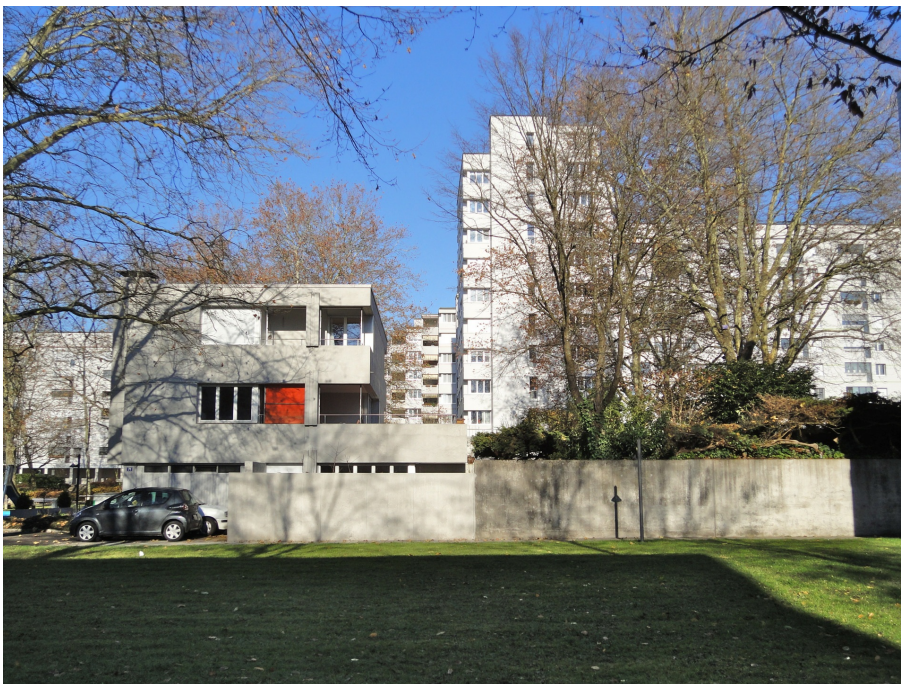
Überbauung Grüzefeld, Pfarrhaus (230MA07340) und Alterswohnungen (230MA07314), Ansicht von S, 29.11.2013 (Bild Nr. D101125_54).
