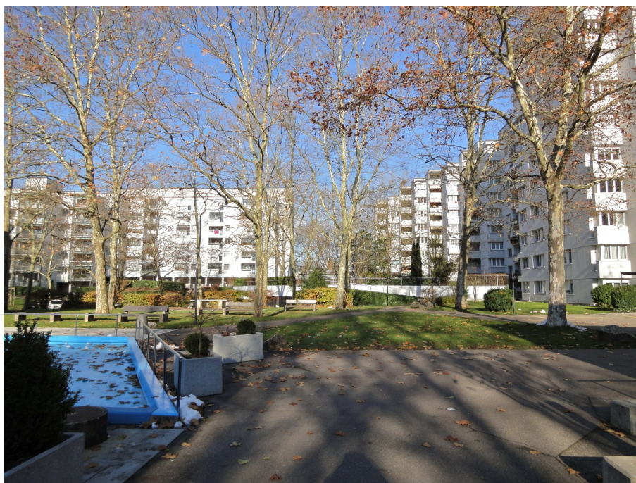
Überbauung Grüzefeld, Innenraum der Siedlung von SW (vorne rechts 230MA07314), 29.11.2013 (Bild Nr. D101125_56).
