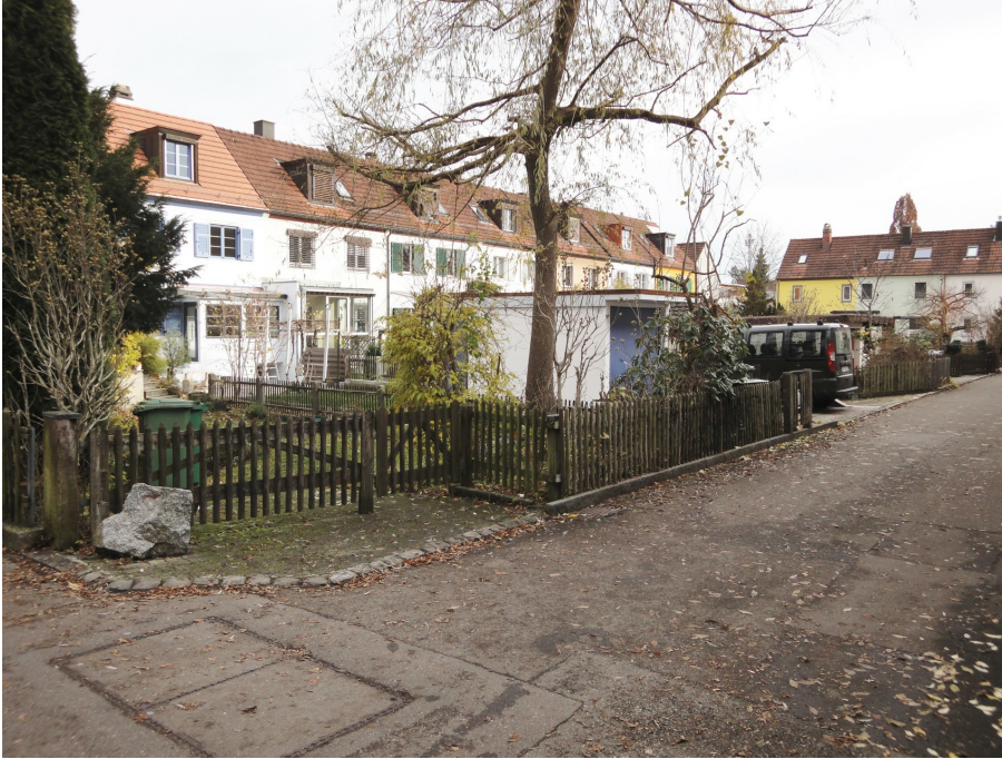
«Selbsthilfe-Kolonie», Blick in den Hafnerweg von W (vorne links 230MA03656), 25.11.2016 (Bild Nr. D101125_35).
