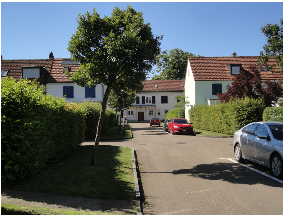
«Selbsthilfe-Kolonie», Siedlungseingang Eigenheimweg, Ansicht von SO, 19.04.2016 (Bild Nr. D101125_37).
