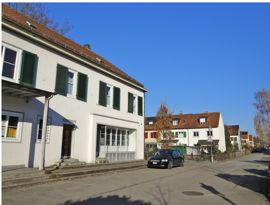
«Selbsthilfe-Kolonie», Blick vom Gemeinschaftshaus (230MA03852, 230MA03853) in den Eigenheimweg, 29.11.2013 (Bild Nr. D101125_32).
