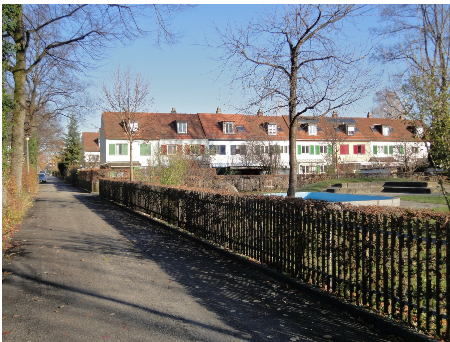
«Selbsthilfe-Kolonie», Blick vom grossen Platz zu den Häusern am Zimmererweg (vorne links 230MA03799), 29.11.2013 (Bild Nr. D101125_34).
