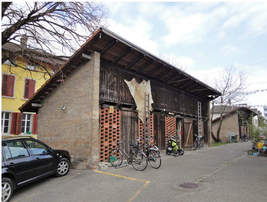
Arbeiterhäuser «Sidi», Schöpfe von 1883 (vorne links 230MA00629), Ansicht von S, 01.09.2016 (Bild Nr. D101125_15).
