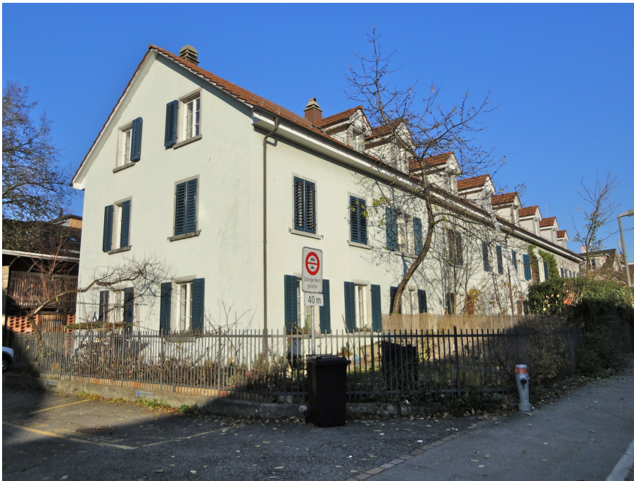
Arbeiterhäuser «Sidi», Häuserreihe Grünenstrasse (vorne links 230MA07620), Ansicht von S, 01.09.2016 (Bild Nr. D101125_13).
