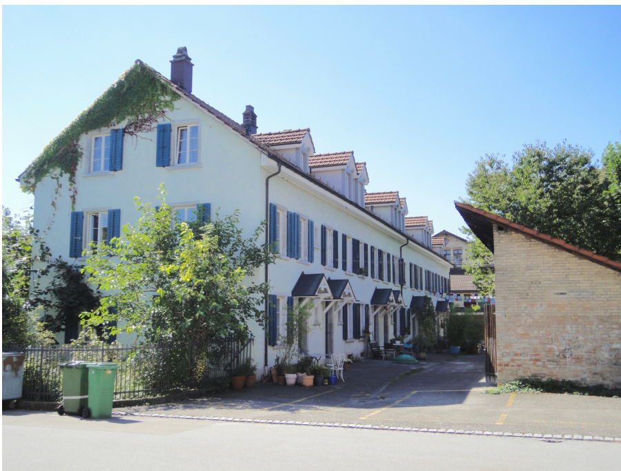
Arbeiterhäuser «Sidi», Häuserreihe Grünenstrasse (vorne links 230MA00945), Ansicht von N, 01.09.2016 (Bild Nr. D101125_12).
