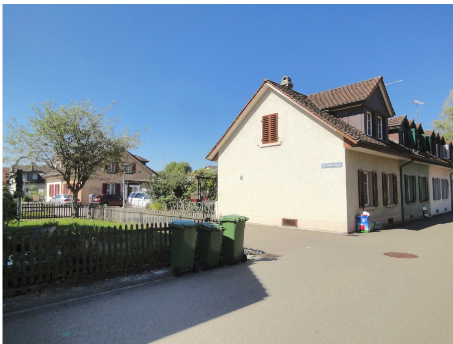
Siedlung Unterer Deutweg, Blick von O bzw, von der Färberstrasse in die Untere Gerberstrasse, 01.09.2016 (Bild Nr. D101125_05).
