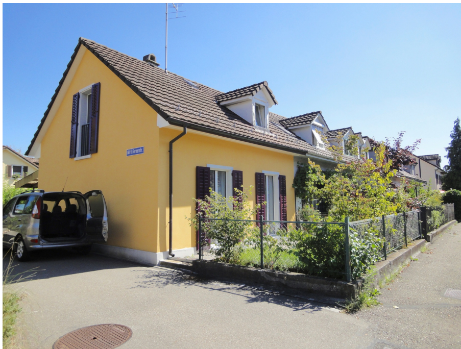
Siedlung Unterer Deutweg, Hausreihe zwischen Weber- und Unterer Schleifstrasse (230MA00842), 01.09.2016 (Bild Nr. D101125_07).
