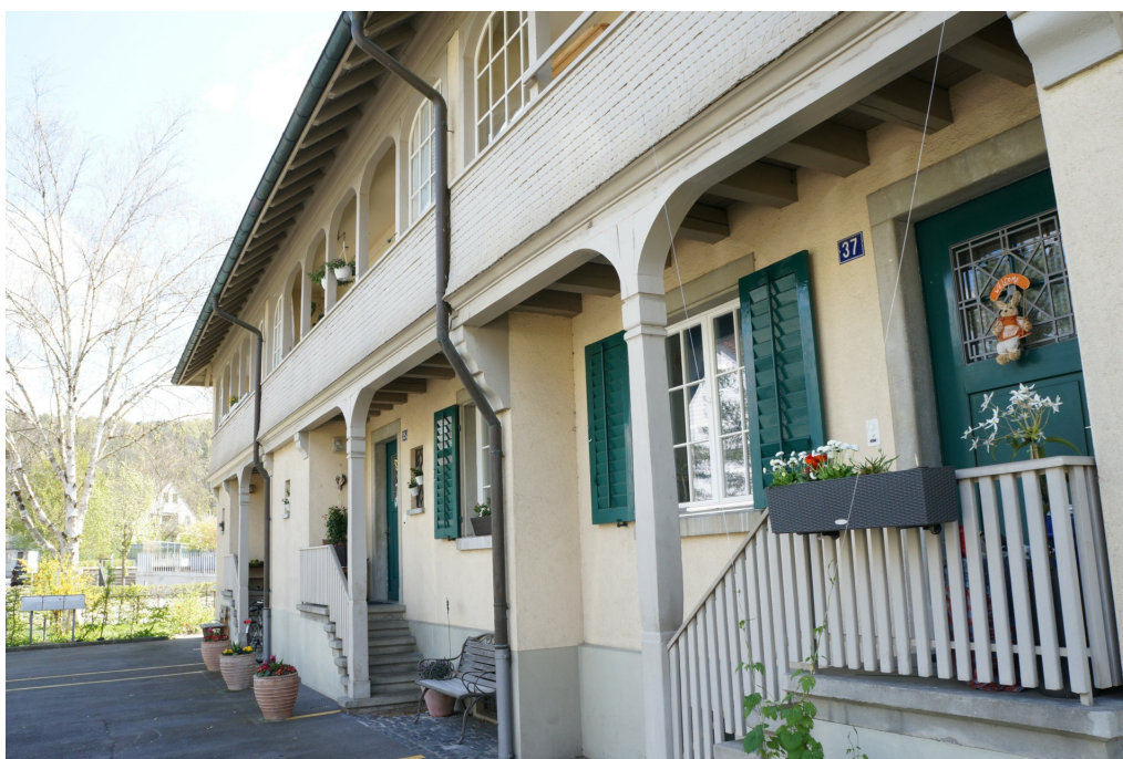
Arbeiterwohnhaus der ehem. Spinnerei Bühler, Eingang des nordöstlichen Hausteils, Lauben-Untersicht, 15.04.2014 (Bild Nr. D100630_05).
