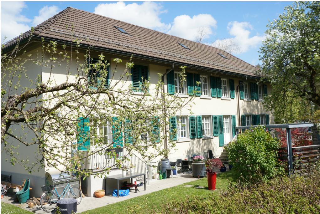
Arbeiterwohnhaus der ehem. Spinnerei Bühler, Ansicht von W, 15.04.2014 (Bild Nr. D100630_07).
