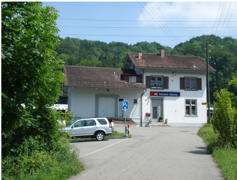
Bahnhof Sennhof-Kyburg, Stationsgebäude, Ansicht von NW, 07.06.2007 (Bild Nr. D100607_24).
