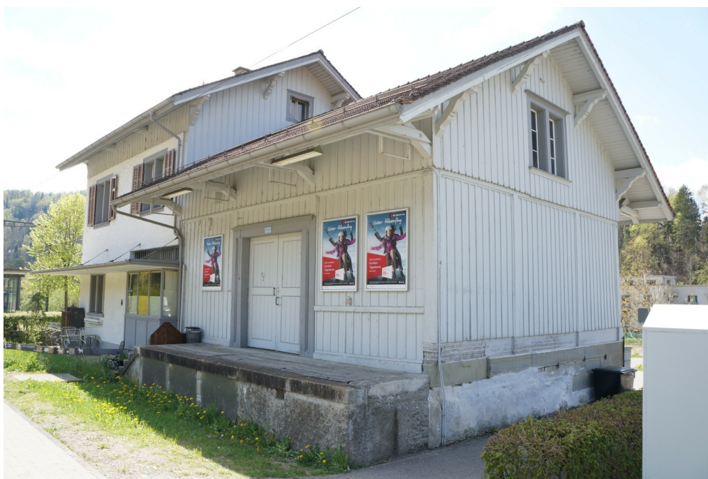
Bahnhof Sennhof-Kyburg, Stationsgebäude, Ansicht von NO, 15.04.2014 (Bild Nr. D100607_40).
