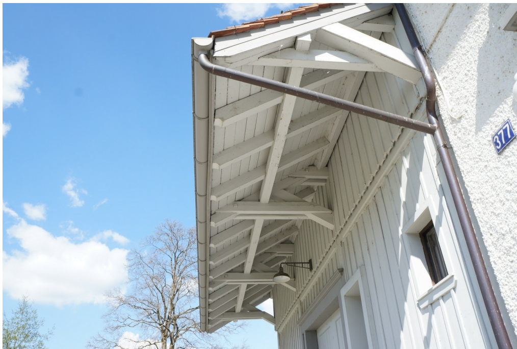
Bahnhof Sennhof-Kyburg, Stationsgebäude, Güterschuppen, Dachuntersicht, Ansicht von W, 15.04.2014 (Bild Nr. D100607_46).
