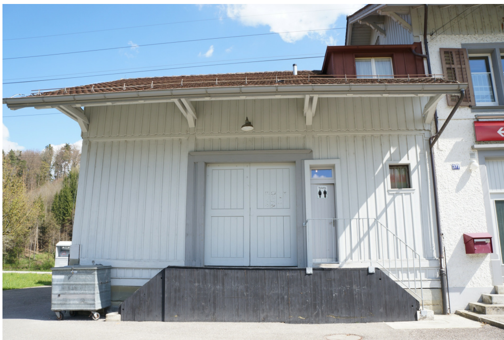
Bahnhof Sennhof-Kyburg, Stationsgebäude, Güterschuppen, Ansicht von W, 15.04.2014 (Bild Nr. D100607_37).
