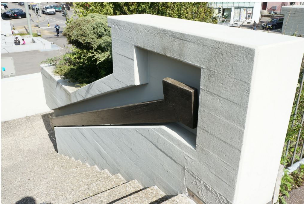
Zentrum Töss und Umgebung, Umgebung (230TOUMGEBU01744), Treppenanlage vom Parkdeck zum Quartierplatz, bauzeitlicher Handlauf, 15.04.2014 (Bild Nr. D100629_31).
