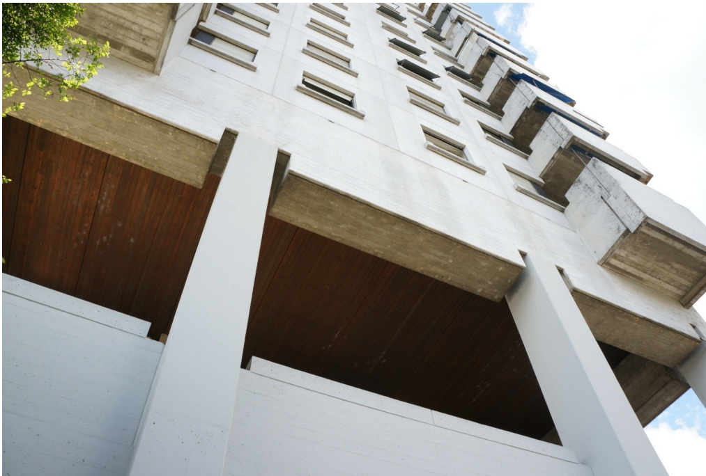
Zentrum Töss und Umgebung, Zentrum Töss (230TO01744), Wohnturm, Betonstützen, Deckentäfer und Plattenstruktur (Detail), 15.04.2014 (Bild Nr. D100629_13).
