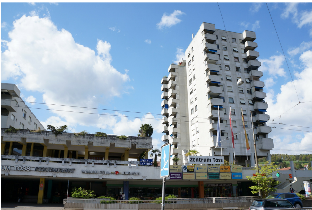
Zentrum Töss und Umgebung, Zentrum Töss (230TO01744), Südostfassade und Wohnturm, Ansicht von SO, 15.04.2014 (Bild Nr. D100629_07).
