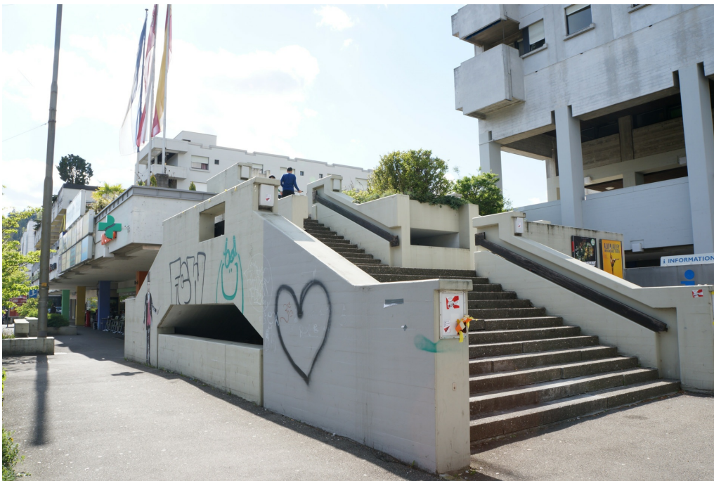
Zentrum Töss und Umgebung, Umgebung (230TOUMGEBU01744), Treppenanlage zum Parkdeck im SO des Komplexes, 15.04.2014 (Bild Nr. D100629_11).
