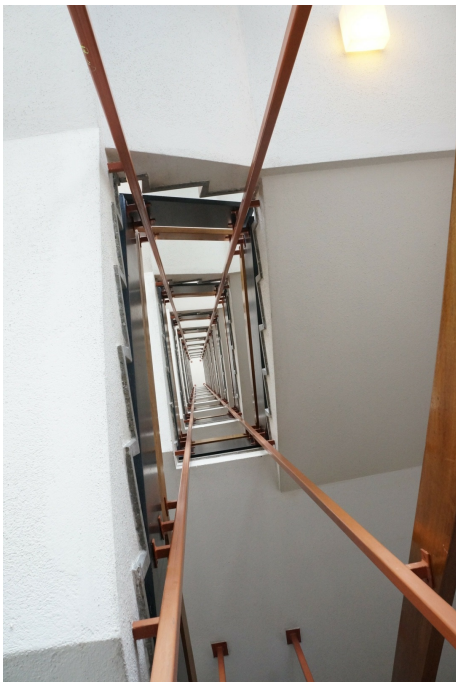
Zentrum Töss und Umgebung, Zentrum Töss (230TO01744), Wohnturm, Treppenhaus, 15.04.2014 (Bild Nr. D100629_16).
