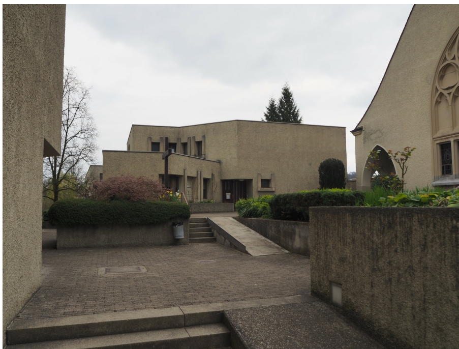
Kath. Pfarreizentrum St. Joseph und Umgebung, Osttrakt (230TO01726), Ansicht von W über den Innenhof, 10.06.2014 (Bild Nr. D100649_20).
