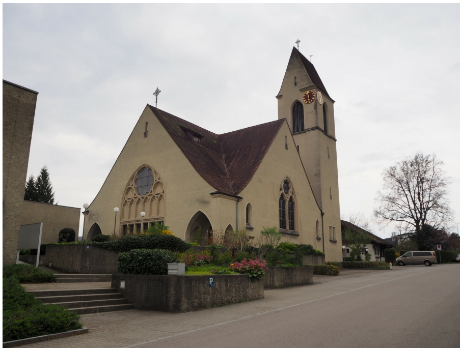
Kath. Pfarreizentrum St. Joseph und Umgebung, kath. Kirche (230TO00230), Ansicht von NW, 05.04.2017 (Bild Nr. D100649_18).
