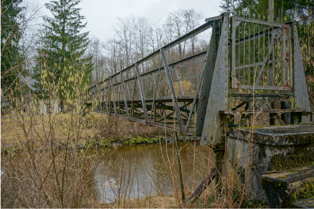
Wasserbauten und Wasserkraftanlagen der ehem. Spinnerei Bühler, Dienststeg (296STEG00002, 230MASTEG00001), Ansicht von S, 23.02.2016 (Bild Nr. D100605_60).
