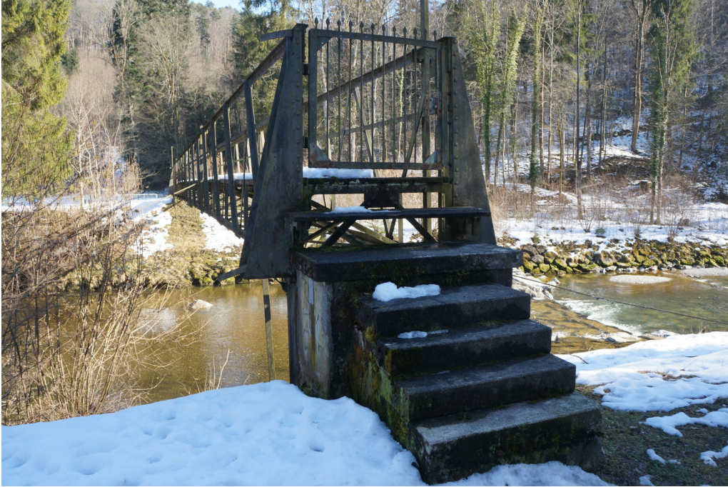
Wasserbauten und Wasserkraftanlagen der ehem. Spinnerei Bühler, nordwestliches Widerlager, Ansicht von NW, 25.02.2015 (Bild Nr. D101068_04).
