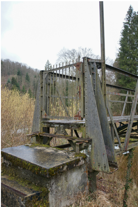
Wasserbauten und Wasserkraftanlagen der ehem. Spinnerei Bühler, Dienststeg (296STEG00002, 230MASTEG00001), Eisengittertor auf dem südöstlichen Widerlager mit Zementtreppe, Ansicht von O, 23.02.2016 (Bild Nr. D100605_61).
