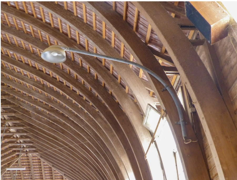
Reithalle, Hetzersparren, 10.01.2017 (Bild Nr. D101638_14).
