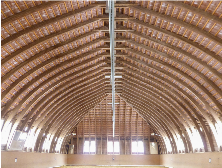
Reithalle, Blick nach SW, 10.01.2017 (Bild Nr. D101638_12).
